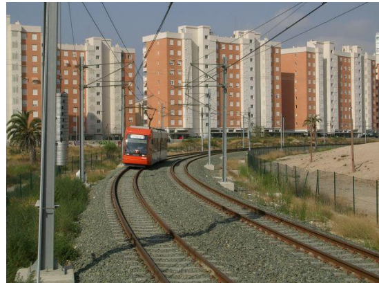
Figura 20. Tranvía de Alicante circulando por vía férrea compartida con material pesado, en entorno interurbano. Fuente: [10]
