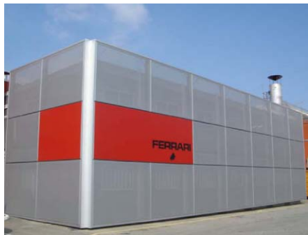
Img. 63 Proyecto de Rehabilitación de Oficinas año 2005 con Panel Modular. La instalación consiste en colocar unos rastreles en la fachada existente, donde se fijan los paneles prefabricados de Taller. 180m2 de Fachada, con una duración de dos días en la instalación. Ubicación en La Tour du Pin- Francia. Sistema Texo. Fuente Fotografía. Catálogo Stamisol V2 de Serge Ferrari.
