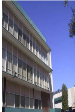
Img.31 Edificio Silver Spur antes de la Rehabilitación, ubicado en Los Ángeles California - USA. "Tras la reforma y la Instalación de la fachada textil, los Gastos Energéticos se redujeron en un 64% además de experimentar un incremento en la ocupación de las oficinas". Fuente, Serge Ferrari.
