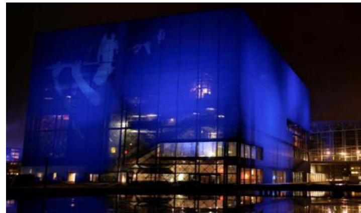
Img. 29 Fachada Envolvente. Concert Hall, Copenhagen, DK. Arquitecto Jean Nouvel. Fuente SergeFerrari.
