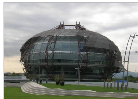
Img. 78 Fachada tipo Muro Cortina con Membrana Textil, Edificio Iguzzini. Fuente N.Bublik
