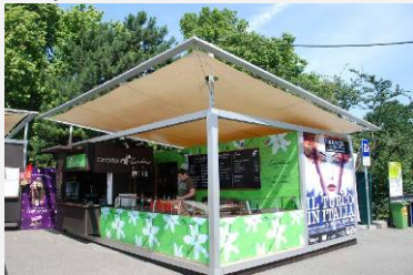
Img.15 Membrana pretensada plana. Stand en Viena, Austria Fuente www.formfinder.at
