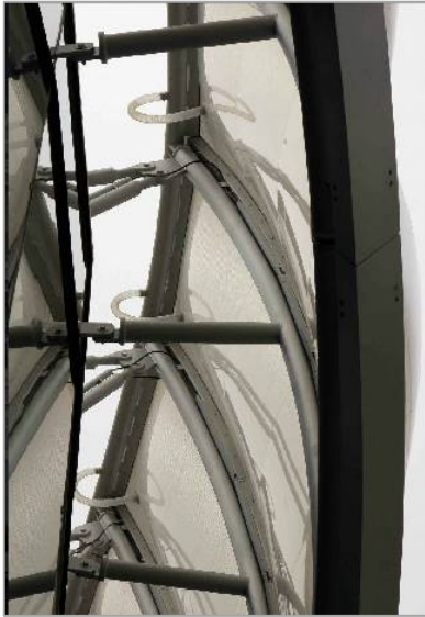
Img.146 Detalle de la Estructura de los Módulos de forma Sinclástica.
