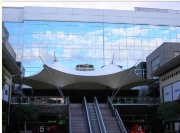
Img.16 Estructura Membrana Tensada doble curvatura (+ y -) Centro Comercial Glòries. Barcelona, España. Fuente N. Bublik
