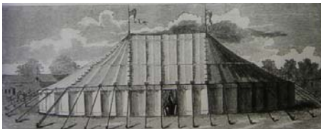
Carpa de circo de "Chapiteau", Tenían 50m de diámetro, hechas de lino o lona de cáñamo tejidos a máquina. Sostenido cerca del centro de 4 mástiles, ubicados alrededor del anillo circense. La lona culega de ellos y están atirantados por cuerdas ancladas al suelo.
