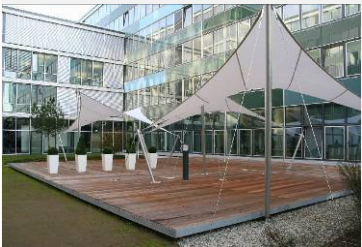
Img.18 Estructura Membrana Tensada doble curvatura (+ y -) Fuente formfinder.com
