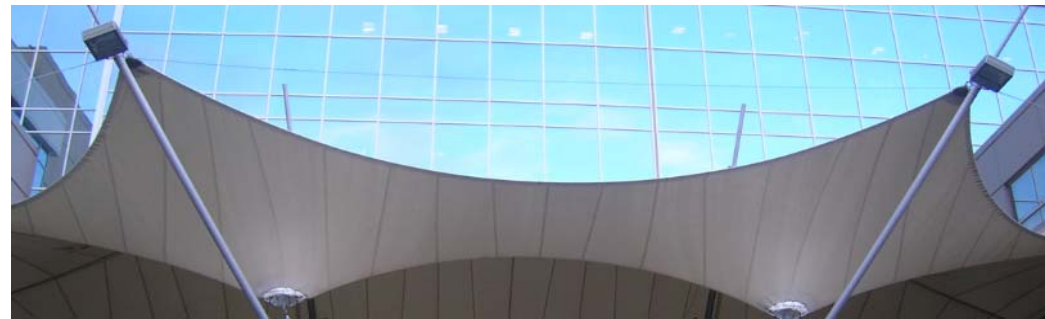
Img. 82 Vista Refuerzo con Borde Flexible con cable interior entre 2 puntos. Centro Comercial Glòries. Barcelona, España. Sistema Tradicional en Estructuras Tensadas. Fuente N. Bublik
