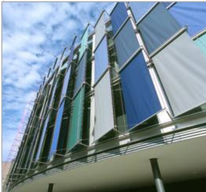
Img. 119 -120 Kreishaus Hameln - Pymont. Fachada con Protección Textil Móvil de Estructura de Aluminio. Año construcción 2003. Fuente http://www.hascherjehle.de
