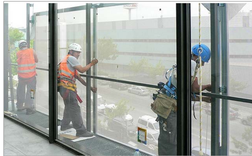
Img. 157 Instalación de Fachada Textil por Empresa Moñita, Miembros de la Asociación Tensinet (Empresas de Arquitectura Textil). Fuente http://www.toldosmoñita.com/fachada-textil.html
