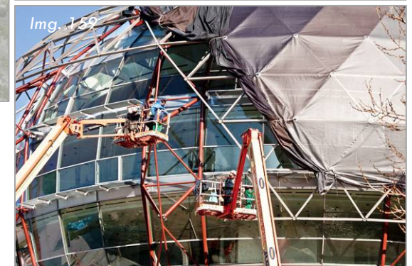
Img. 157 Instalación de Fachada Textil por Empresa Moñita, Miembros de la Asociación Tensinet (Empresas de Arquitectura Textil). Fuente http://www.toldosmoñita.com/fachada-textil.html
