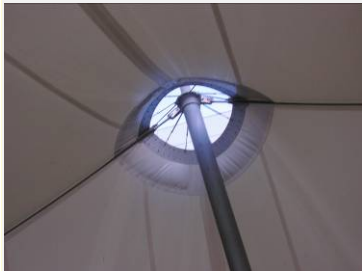
Img.17 Detalle Mástil Membrana Fuente Fotografía N. Bublik
