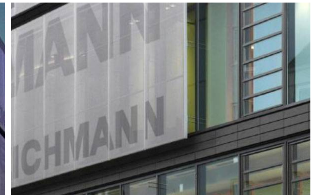
Img. 71 Mallas microperforadas. La separación de la piel interior, facilita la cobertura de redes de la edificación y minimiza el ruido desde el exterior.
