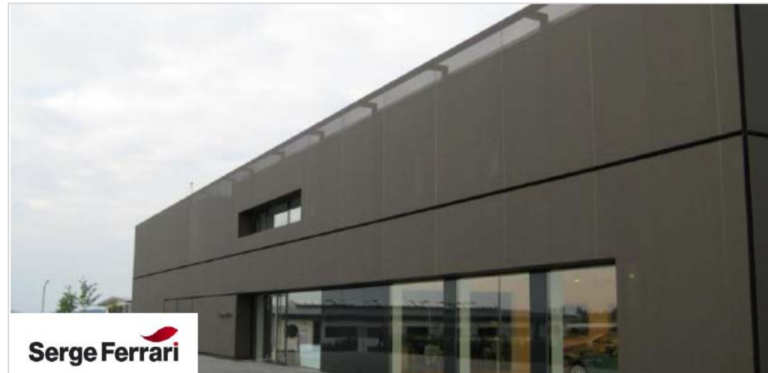
Img. 62 Imagen Showroom Aston Martin Test Center, Nürburgring, Germany. Fuente SergeFerrari, producto Stamilol FT.
