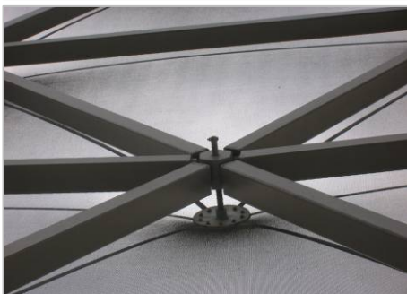
Img. 74 Fijación Puntual de la membrana a la estructura auxiliar. Fotografías N. Bublik
