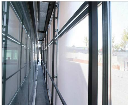
Img. 69 Edificio Oficinas Tripark Las Rozas. Madrid-España, año 2009. De Geometría Ceroclástica. Fuente: www.batspain.com
