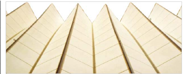
Img. 93. Soportes Lineales, Cables en los Valles y Elementos de Cresta Rígidos dan una forma ondulada a una fachada o cubierta.
