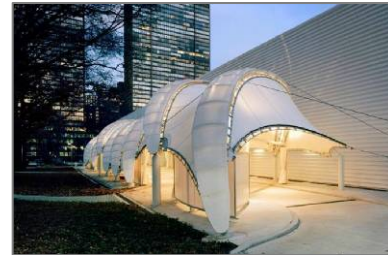
Img. 92. Arcos Lineales en diferentes direcciones, configuran formas heterogéneas. Porte Cochere, New York. 2010. Fuente Formfinder.com
