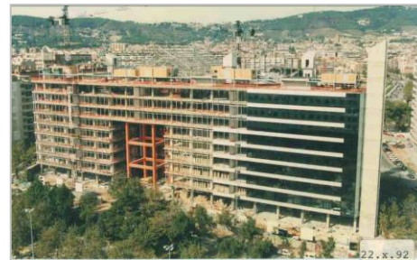
Img 188-189. Proceso constructivo del muro cortina de la Fachada Sur. Años 1992-93. Fuente Ferrés Arquitectos y C.
