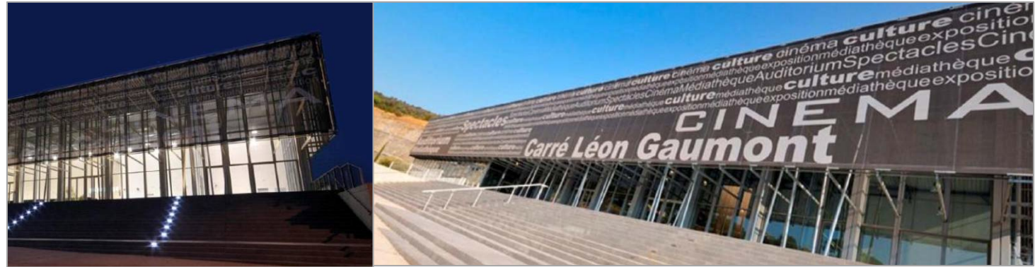
Img.34 Fachada de doble piel, su piel exterior está conformada por una estructura textil tensada plana. La imagen transmite un mensaje. Se utilizó el producto Stamisol FT. Arquitecto Jean Pascal CLEMENT. Fuente Fotografía Catálogo Stamisol FT 381 & Color SergeFerrari Architecture Fachada. Octubre 2010. P 11
