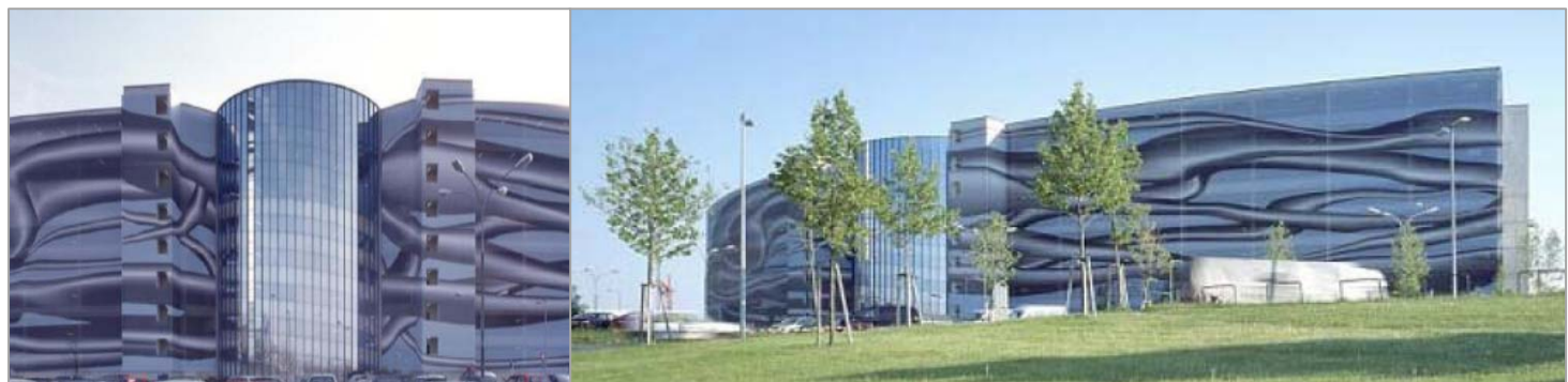
Img.35 Aparcamiento Flughafen, Vienna – Austria. Arquitecto Kogler. Fuente Catálogo Stamisol FT 381 & Color SergeFerrari Architecture Fachada. Octubre 2010. P 23
