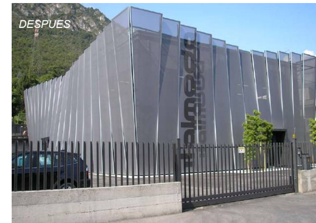
Img. 32 Edificación Industrial, Rehabilitación Italmoda Factory 2008, Bergamo-Italia con TEXO. Fuente Catálogo Stamisol SergeFerrari.
