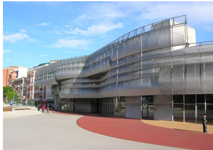
Img. 131-132 Proyecto Centro Audiovisual Multimedia Magical en Lleida-España, utiliza Membrana de Fibra de Vidrio PTFE y Fibra de Vidrio Silicona. Formas complejas de doble curvatura. Fuente IASO.es.
