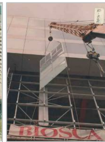
Img 188-189. Proceso constructivo del muro cortina de la Fachada Sur. Años 1992-93. Fuente Ferrés Arquitectos y C.
