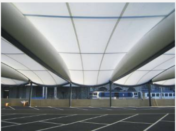
Img.9 Cubierta estacionamiento en estación ferroviaria de 28mts de luz, Montreux, Suiza 2004. Fuente
