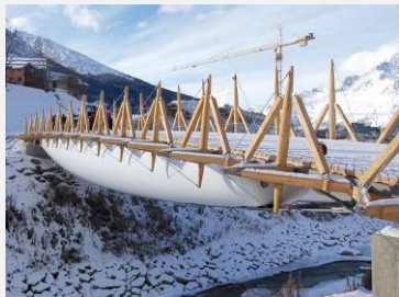
Img.8 Puente de 52mts de luz, en Val Cenis, Francia 2006.
