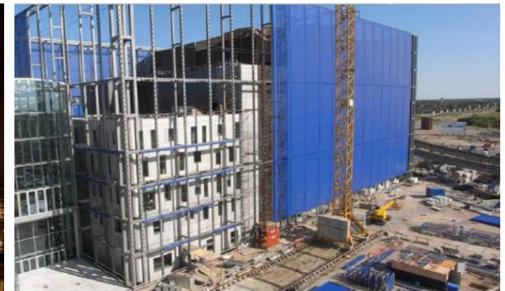
Img.30 Fachada Envolvente en Construcción. Concert Hall, Copenhagen, DK. Fuente SergeFerrari.
