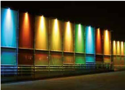
Img.33 Fachada Iluminada, compuesta por una doble piel. La piel externa de cristal y la piel interior textil. Comunas de Bermex et Confignon Suiza. Arquitectos Devanthery & Lamunière. Fuente Catálogo ES_SergeFerrari_The Architecture Book. P 41
