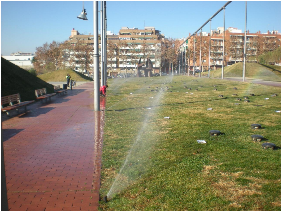
Imatge 7. Efectes de la mala regulació d'un aspersor.
