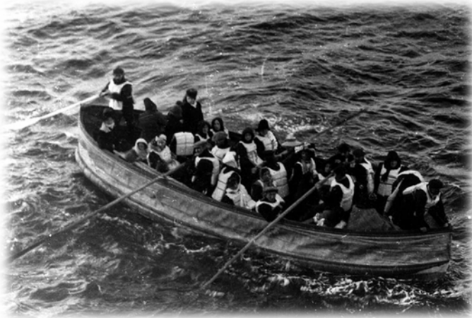
· Foto 7: bote D plegable del tipo Englehardt, con el detalle que los costados eran de lona.
