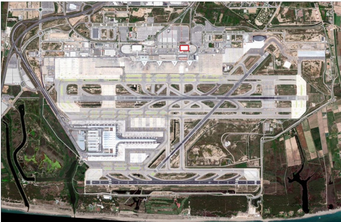
Fig.2.23. Ubicación del aparcamiento T2-C [F3].
