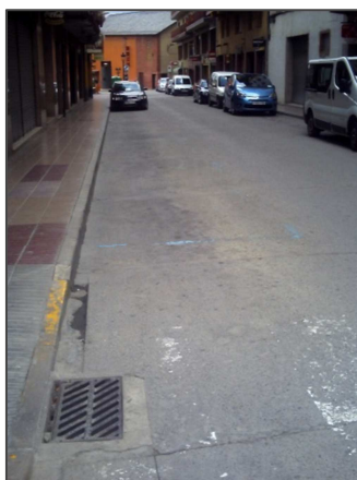
Figura 4.11. Carencias en la señalización horizontal en la c/Major (prolongación). [Fuente: J. Espejo]
