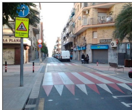
Figura 2.2. Paso de peatones elevado.
