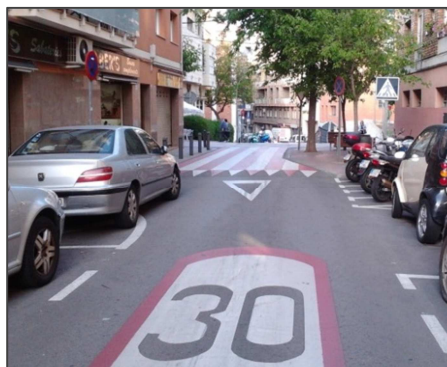
Figura 2.1. Estrechamiento de calzada.
