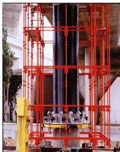
**Fig. 21.** Aplicación de FRP mediante bobinado automático en un pilar circular
