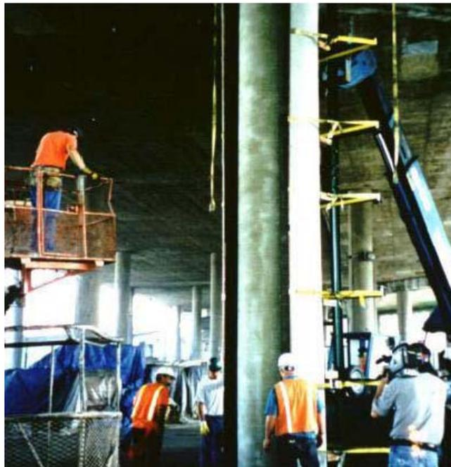
**Fig. 22.** Aplicación de una camisa prefabricada de FRP en un pilar circular
