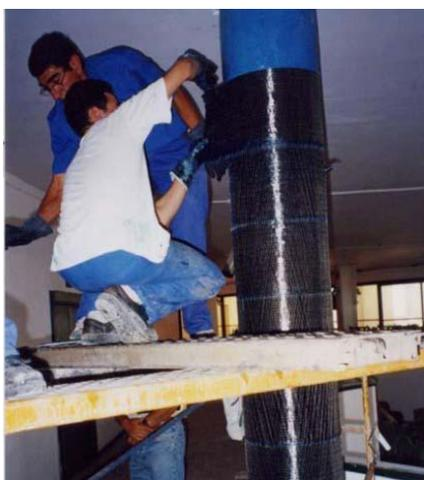
**Fig. 20.** Aplicación de FRP mediante la técnica de *wrapping* en un pilar circular
