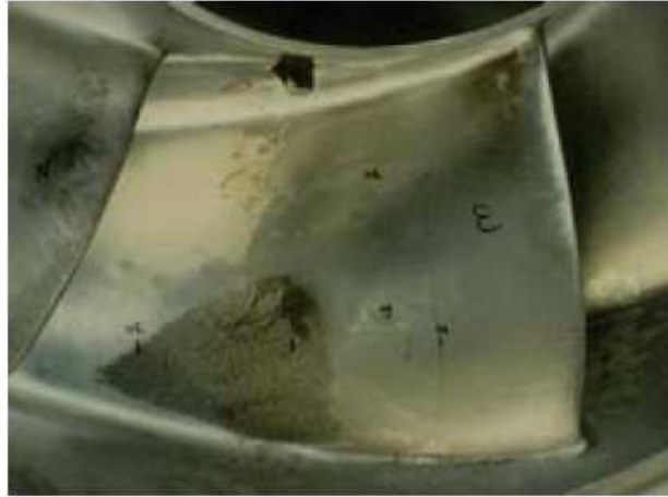
Figura 50: Álabes deteriorados debido a la cavitación
