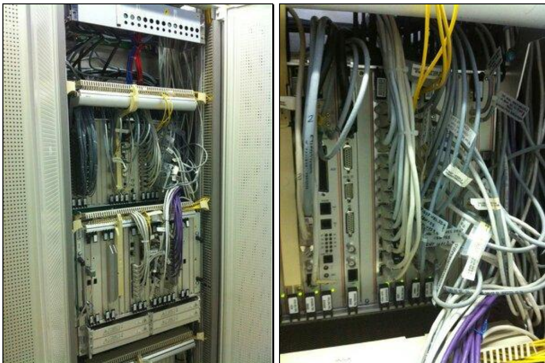
Equip SDH STM-4 d'Alcatel. Combina targetes PDH / Eth / FO
