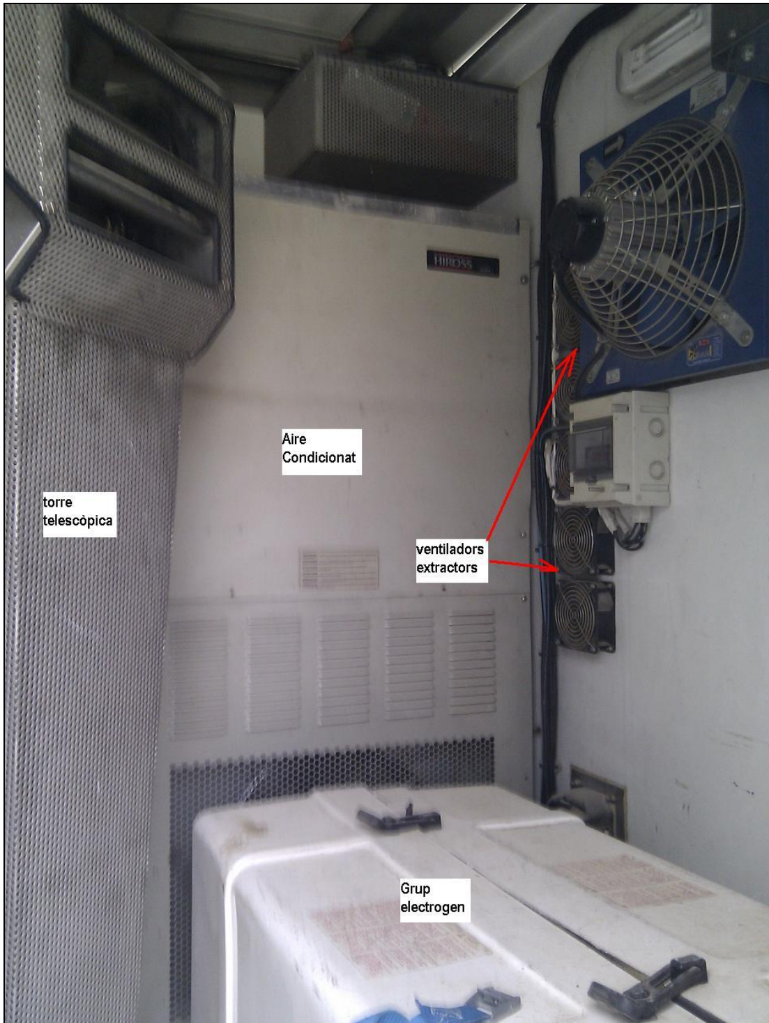
Detall movishel20, sala mecànica
