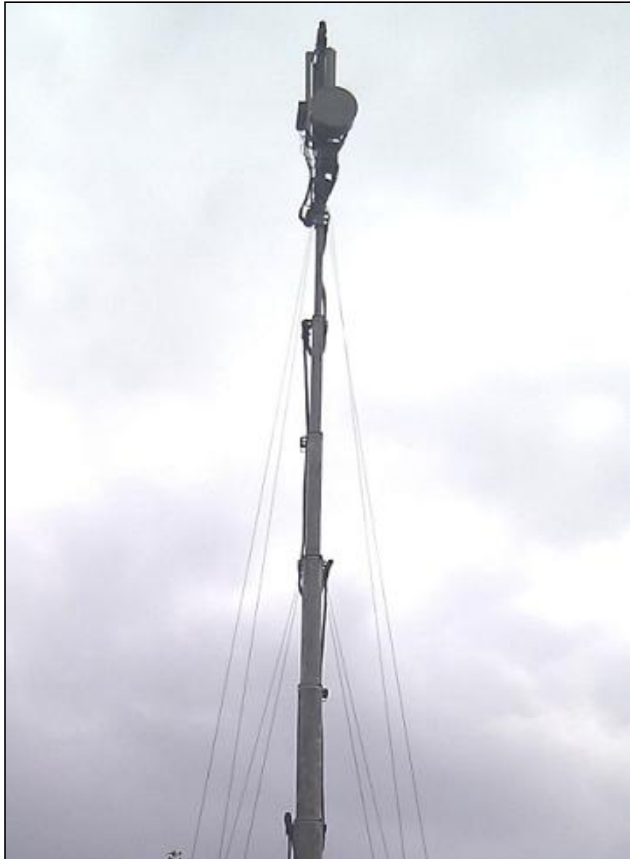
Pal telescòpic hissat i cables tensors col·locats
