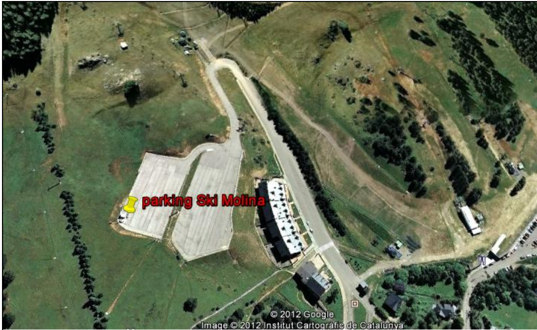
Situació de la nova Estació Movistar “Molina Parking”.
