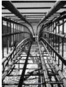
Figura 1.1 - Armadura d'acer abans del formigonat
