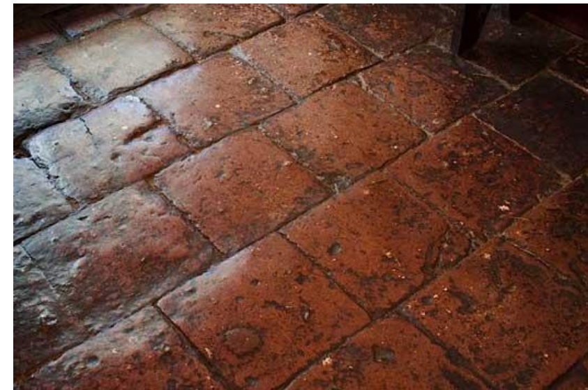
12.- Pavement of clay tile. Data: http://madrid.comparentuciudad.com/p_arterania/rustico-diego-ruiz-madrid_9792
