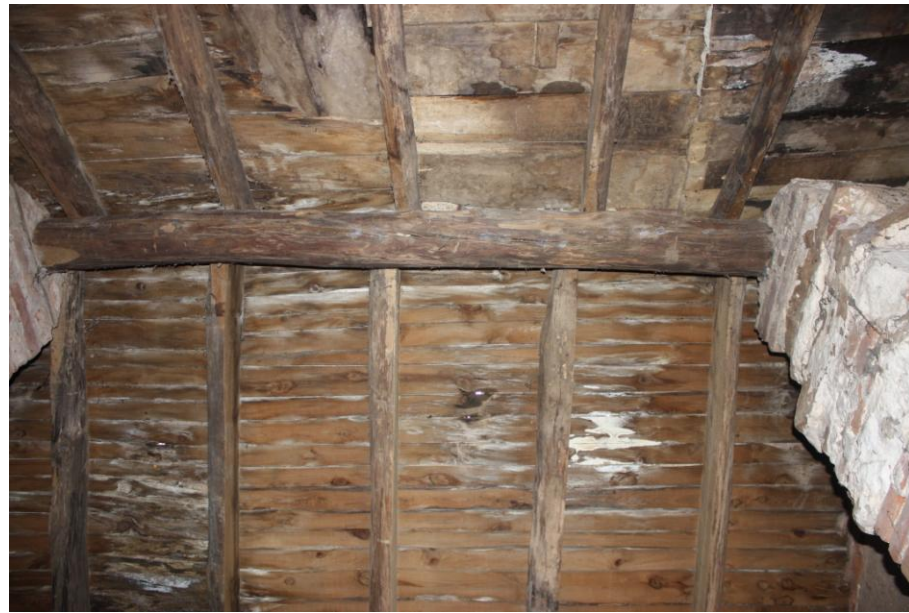
10.- Deck structure "par y picadero".
