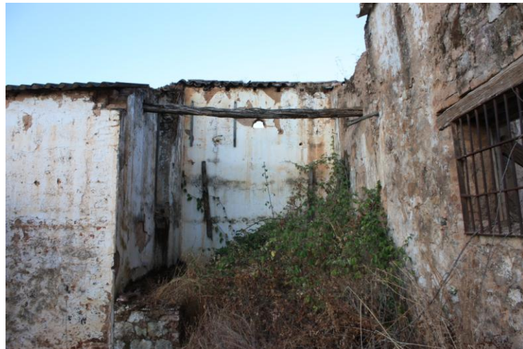
45.- Cubierta a la molinera que forma el hueco de acceso a la cámara.
