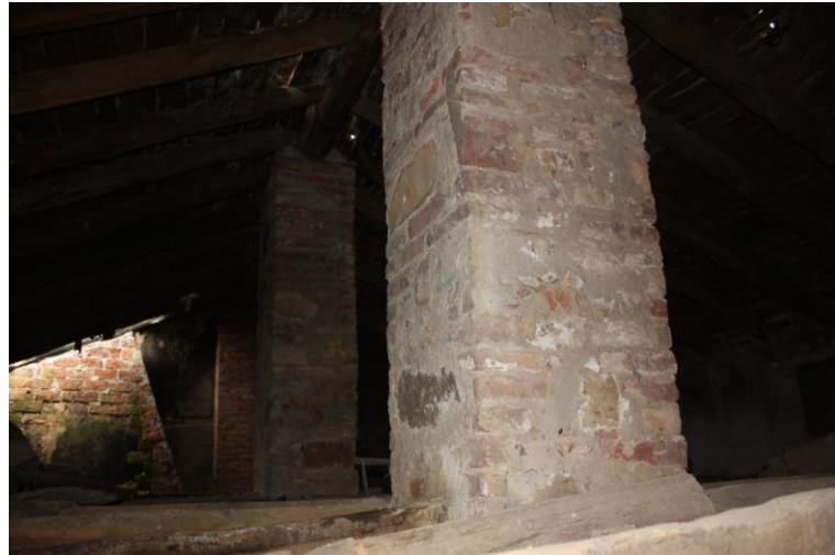
32.- Pilar de fábrica de ladrillo del interior de la vivienda principal.
