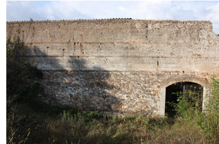
30.- Muro de tapial que forma la fachada exterior suroeste.
