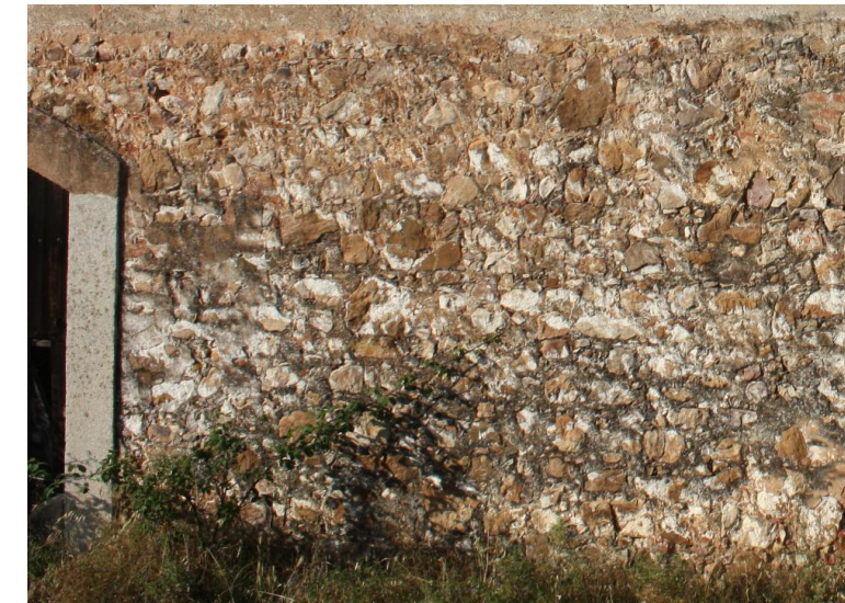
27.- Muro de piedra junto a la entrada principal al patio.
