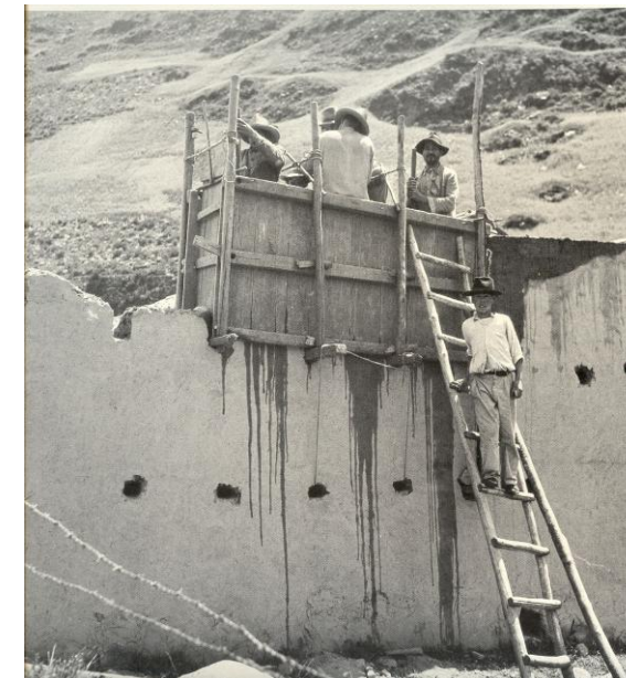
2.- Workers build tapial wall. Data: http://www.farfanestella.es/bioclimateca/
