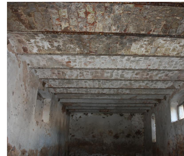
44.- Forjado de vigas metálicas sobre el almacén del grano.
