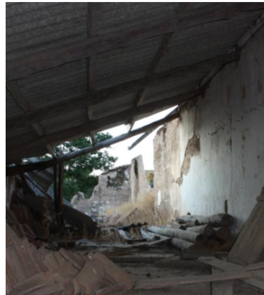
50.- Imagen interior de la cámara.
