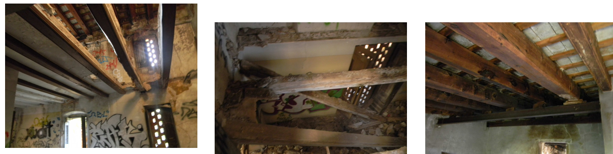
Fig. 17. Grupo de figuras. Varias fotos que muestran el estado de los forjados del edificio principal.
