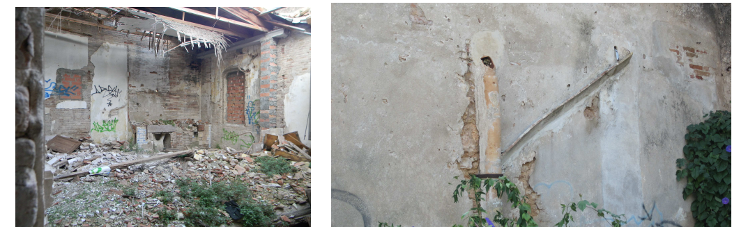
Fig. 18. Grupo de figuras. A la izquierda, el interior de donde estaban ubicados baño y cocina. A la derecha, bajante de éstos con destino una fosa séptica.
