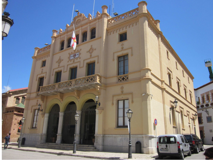
Fig. 11. Vista de la fachada principal del Ayuntamiento de Sitges. En la parte más alta se aprecia el año de construcción, 1889.
