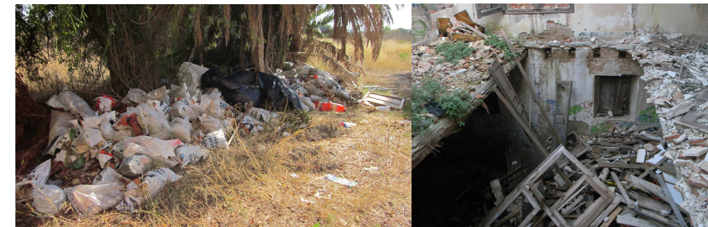
Fig. 19. Grupo de figuras. Escombros de obra en el interior y de basura en general en el exterior.
