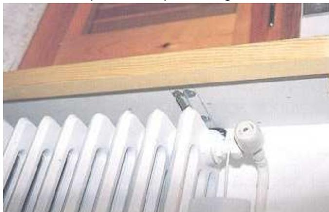
Figura 6.8: Aplicación de las placas de cartón para proteger estanterías sobre radiadores. (Fuente: Manual per a la diagnosi i el tractament de l'amiant a la construcció, Ramón Graus [et al.], CAATB, pág. 18).
