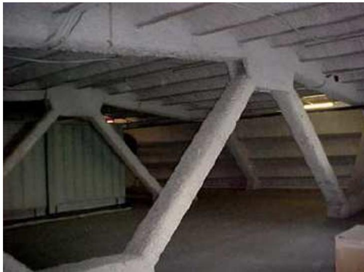
Figura 6.3: Protección ignífuga y revestimientos termo-acústicos de estructuras metálicas. (Fuente: pág. 62 Guía Técnica del RD 396/2006 del INSHT)
