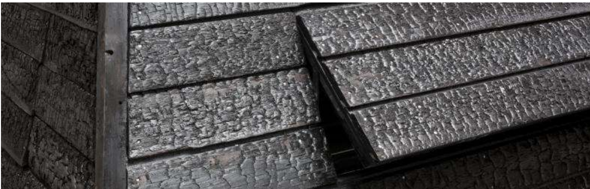
Figura 3.2 Madera protegida con la técnica Shou-sugi-ban [11]
