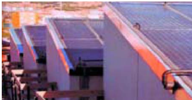
Figura 2. Captadores sustituyendo a materiales de cubierta
