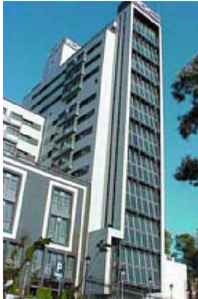
Figura 7. Integración de captadores en fachada
