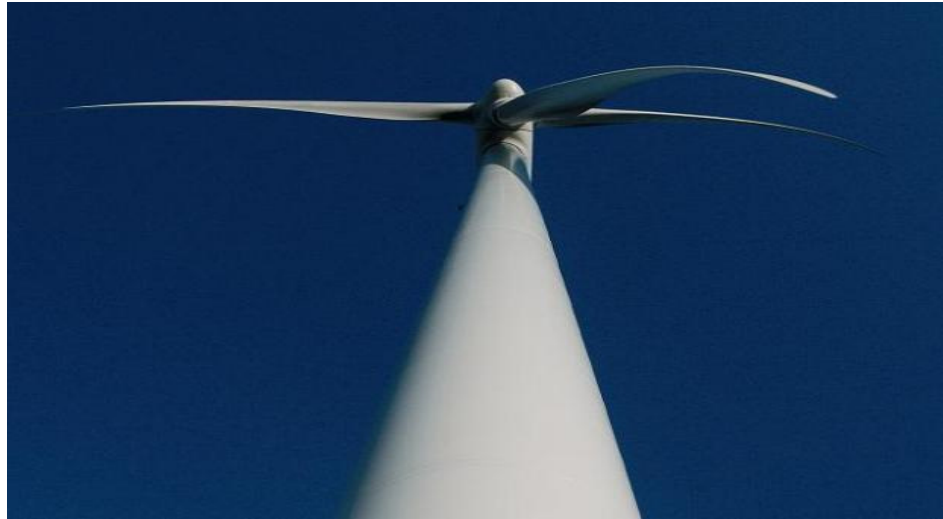
Figura 4: Vista de un V90 donde se aprecia el efecto flector del viento en las palas
