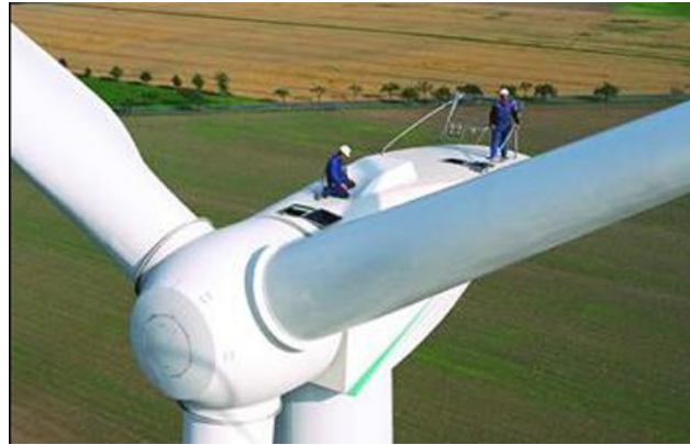
Figura 3: Equipo de operarios trabajando en una góndola en tareas de mantenimiento.
