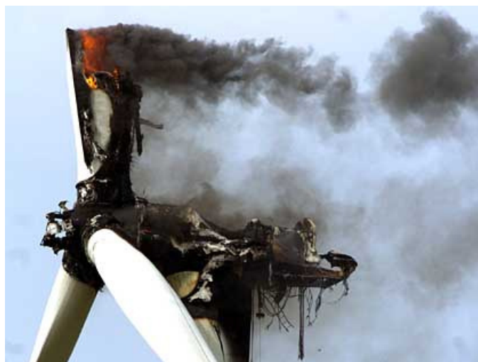
Figura 2: Destrucción de toda la góndola y las palas de una turbina eólica provocada por un daño en el generador.
