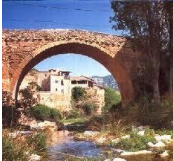
Fig.2.1.2. Pont d'accés a Beseit
