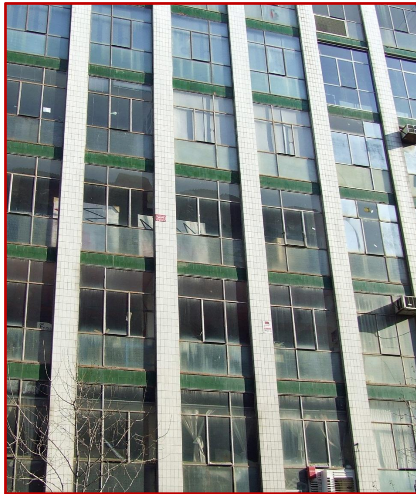
fig. 2 - Detalle de la fachada
