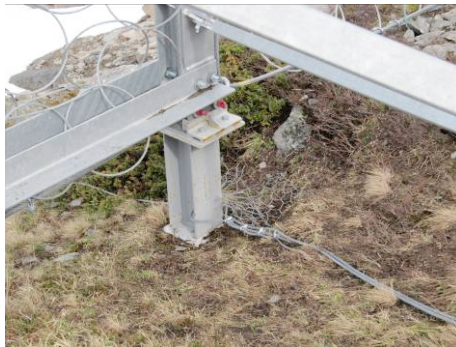
Photo 5. Poteaux du module, appui simple
