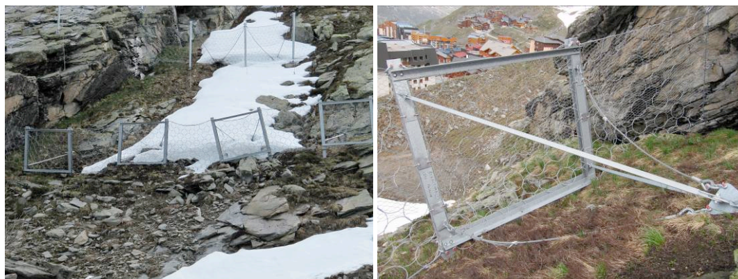
Photo 2 : installation du filet mono-ancrage, Val Thorens.
