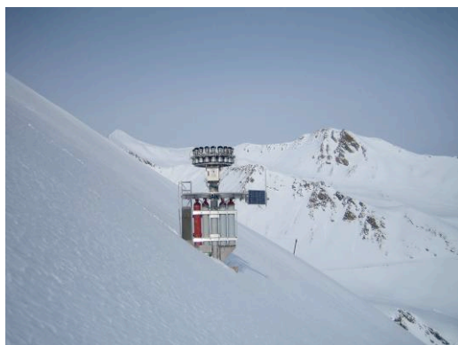
Photo 1 : Système paravalanches active non permanent Avalhex ®
