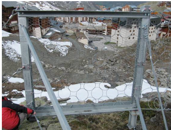
Photo 3 : vue d'un module depuis l'amont
