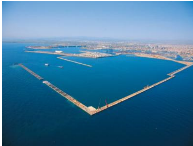
Dique de abrigo de la nueva ampliación
