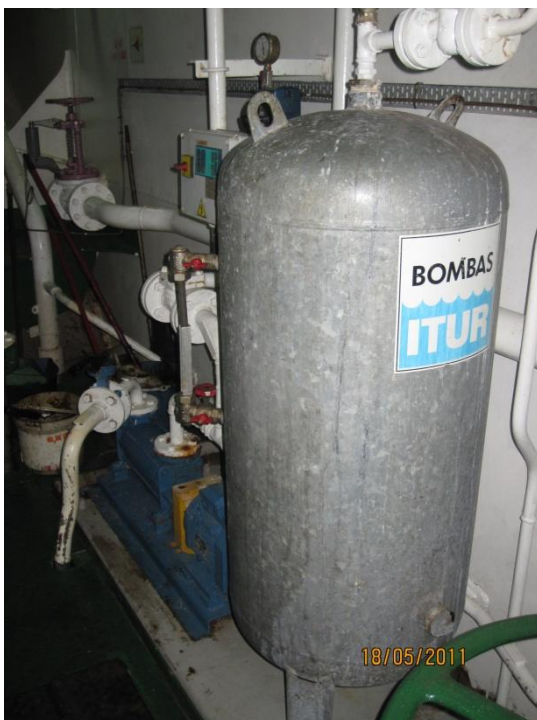
Exemple de tanc hidròfor amb la seva bomba d'autoencebat.
