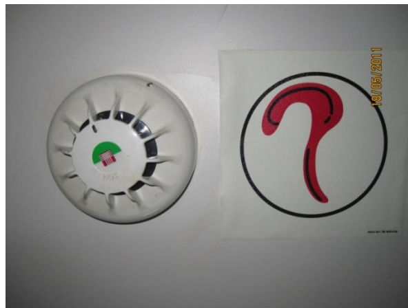
Exemple d'un detector de fum
