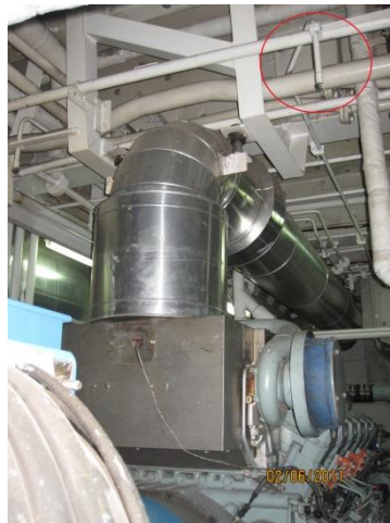
Indicació de la localització de l'atomitzador d'aigua.
