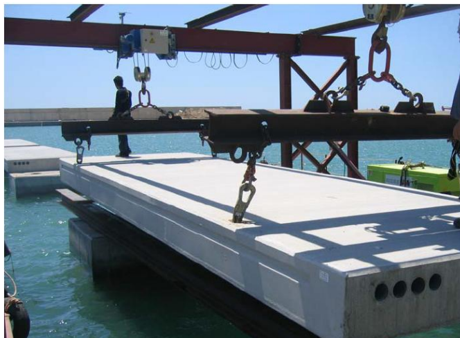
fig. 13, Grua sofisticada per issar pantalans
