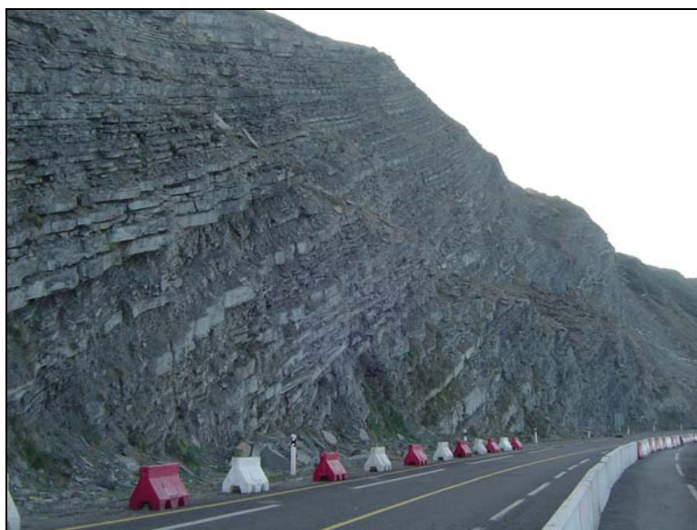
Figura 5-4. Exemple d'alternança de calcàries argiloses i argilites en estrats de gruix decimètric i centimètric. Font: Jordi Corominas.
