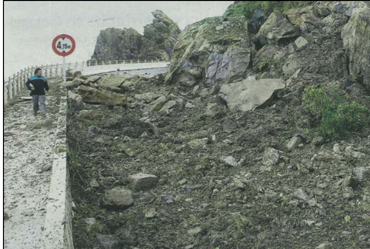
Figura 5-8. Despreniment del 5 de desembre de 2008 al P.K. 21+750 on s'aprecien blocs superiors als 10 m 3 i material de granulometria inferior envaint els dos carrils. Font: El Diario Vasco.
