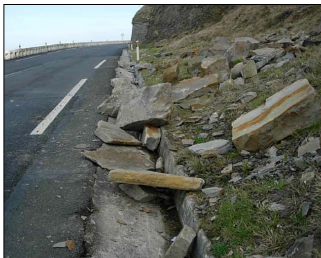
Figura 5-14. Exemple de fotografia d'un despreniment rocós que inicialment havia quedat enregistrat amb el comentari de "retirar pedres".
