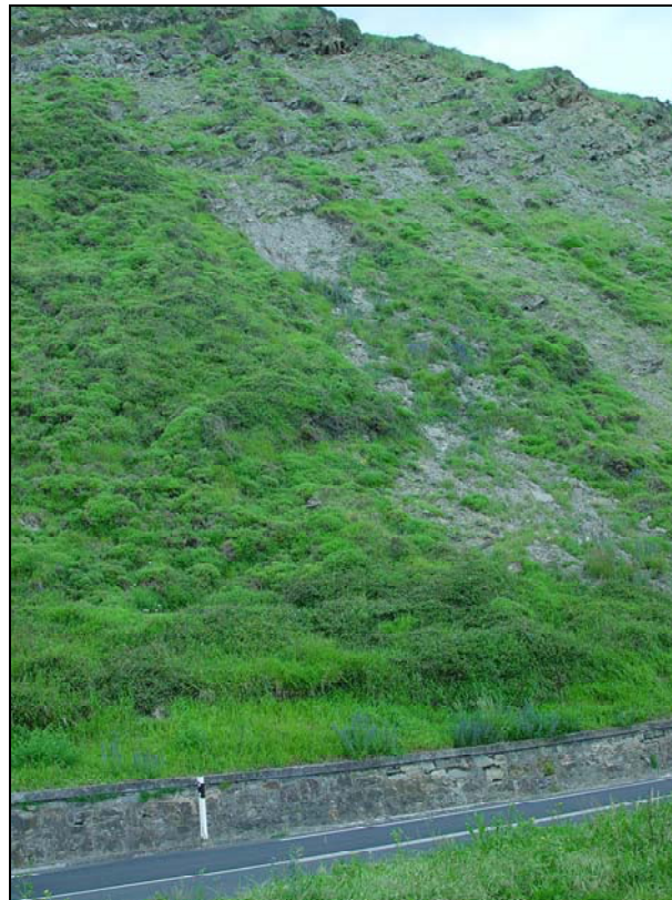
Figura 5-13. Exemple de zona on es poden donar desprendiments provinents de la part superior i corrents d'arrossegalls de forma simultània. Font: Jordi Corominas.
