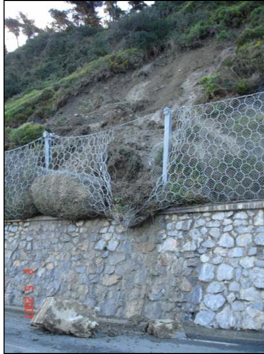
Figura 5-15. Exemple de fotografia d'un corrent d'arrosseballs que inicialment havia quedat enregistrat amb el comentari de "retirar pedres".
