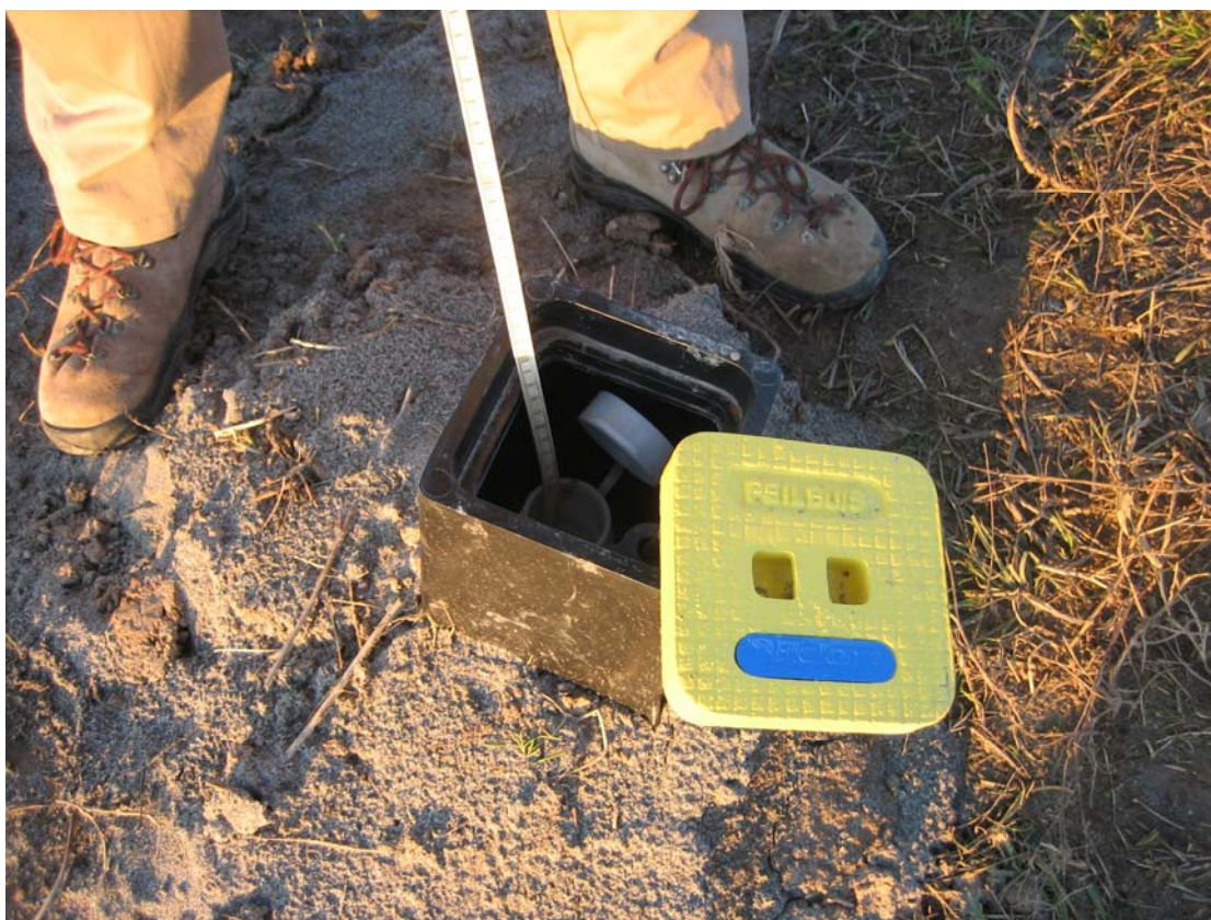
Fig.4. Mesura manual del nivell piezomètric després de la instal·lació del piezòmetre.
