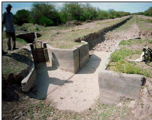
Fig.42: Exemple de derivacions amb caixes divisòries al Canal del Plato (Atamisqui). Font: Arumí, 2008.
