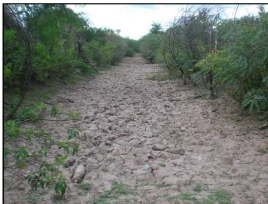
Fig17. Estat de la derivació a Villa Matoque, amb origen al Canal Virgen de Huachana, pel qual no hi circula aigua a causa d'un trencament al marge del canal origen.
