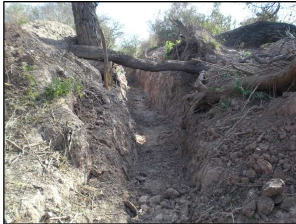
Fig.39: Canal de secció rectangular excavat a terra de la comunitat de regants del Rio Salado al paraje del Arroyo.
