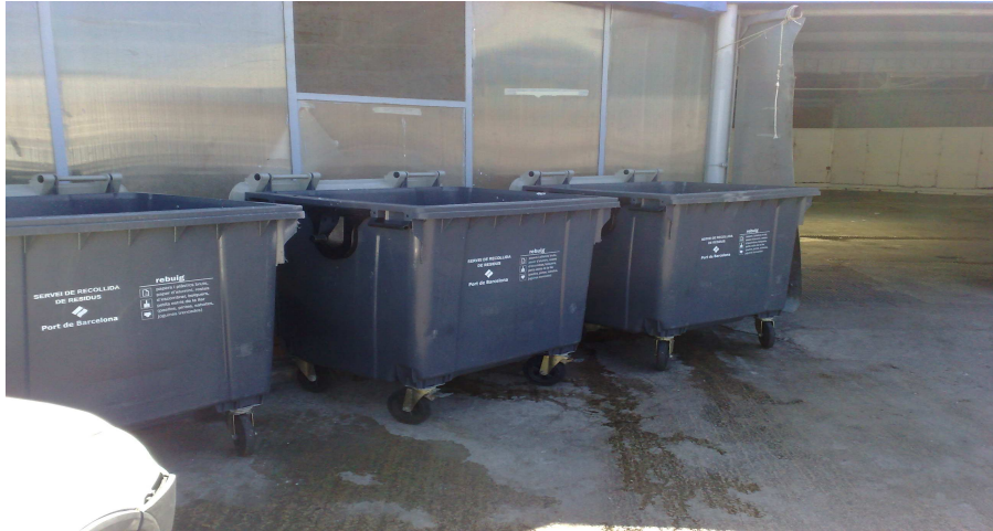
Foto 15. Se aprecia una zona de contenedores de residuos totalmente accesibles dentro de la instalación. Existen más contenedores del mismo tipo colocados en diversos puntos de la instalación. Se encuentran abiertos, por lo que en caso de lluvia pueden inundarse y provocar nefastas condiciones higiénicas y de salud para los trabajadores. La zona de alrededor esta visiblemente sucia y mojada.
