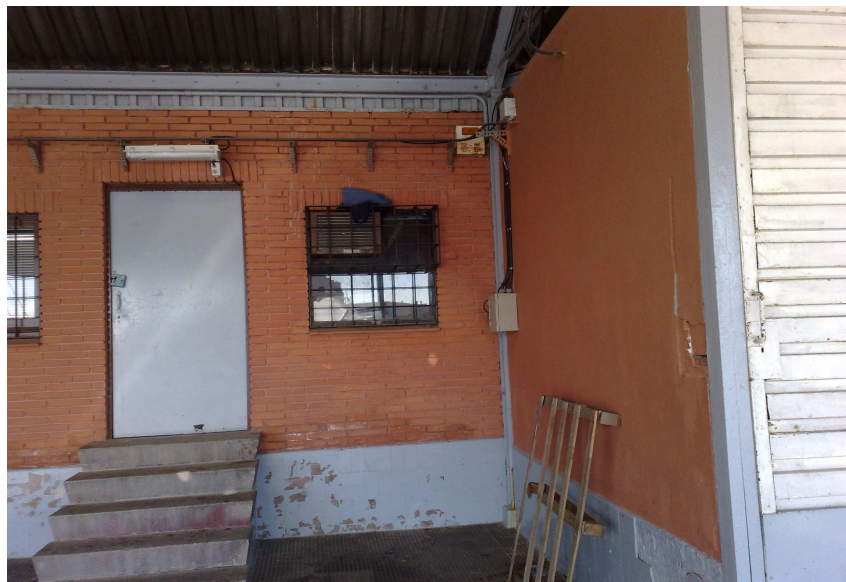
Foto 2. Las ventanas se encuentran sucias, además de estar en muy mal estado. Sin embargo, el sistema de iluminación se encuentra bien mantenido y limpio de sustancias orgánicas, insectos, etc.
