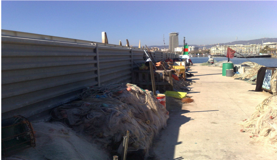
Foto 11. Se aprecian diversos materiales apilados, sin señalar la zona, sin identificar e invadiendo la zona de paso de los trabajadores. Estos materiales se apilan de manera insegura y mostrando gran suciedad y falta de orden e higiene.
