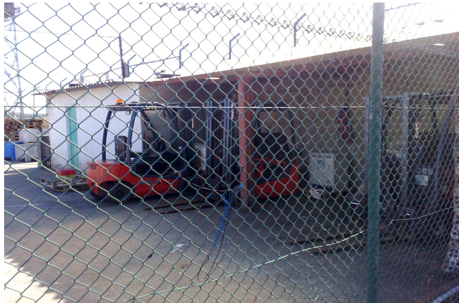
Foto 8. Zona de estacionamiento de carretillas mecánicas. El mal estado de los suelos no facilita su circulación.
