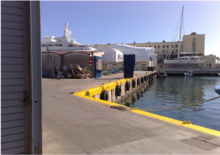
Foto 5. La señalización es correcta y se halla en buen estado.
