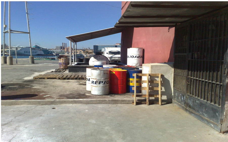
Foto 16. La imagen muestra la estación Marpol de la instalación donde se aprecia una serie de bidones metálicos que almacenan residuos inflamables. Estos bidones se encuentran cerrados pero no muestran ningún tipo de sujeción. Provoca un impacto visual negativo.
