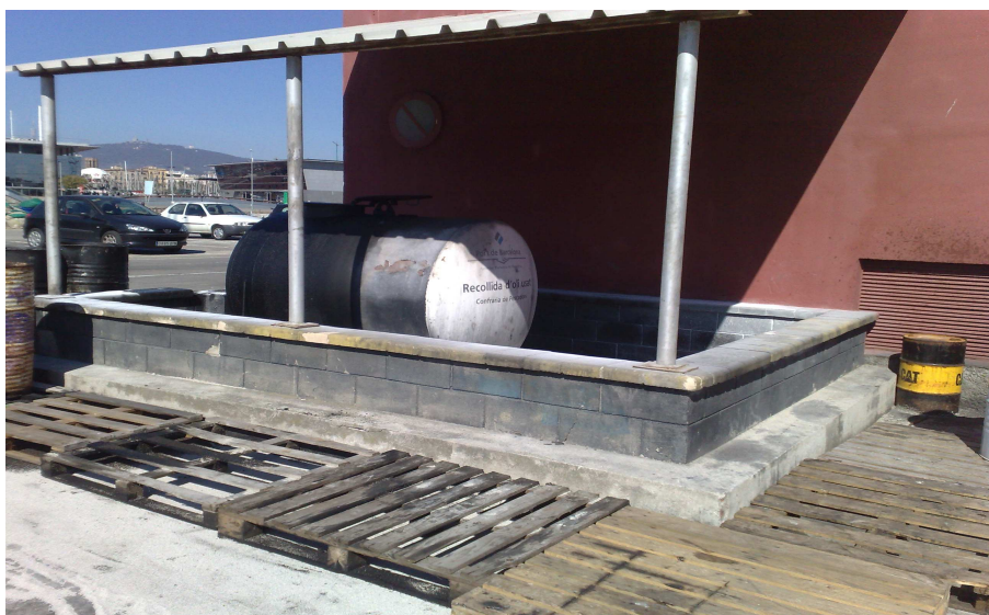
Foto 17. La imagen sigue mostrando otra parte de la estación Marpol, donde se encuentra un gran contenedor cilíndrico de aceite usado totalmente cerrado y alejado unos metros de los bidones anteriores. No se encontró ningún medio de limpieza alrededor de los contenedores ni bidones. La zona de alrededor estaba impregnada de grasas y aceite.
