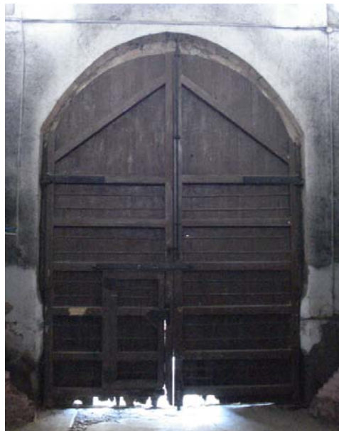
Puerta entrada (vista interior)
