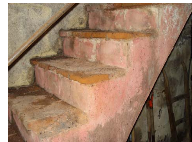
Escalera de acceso a la zona superior de descarga
