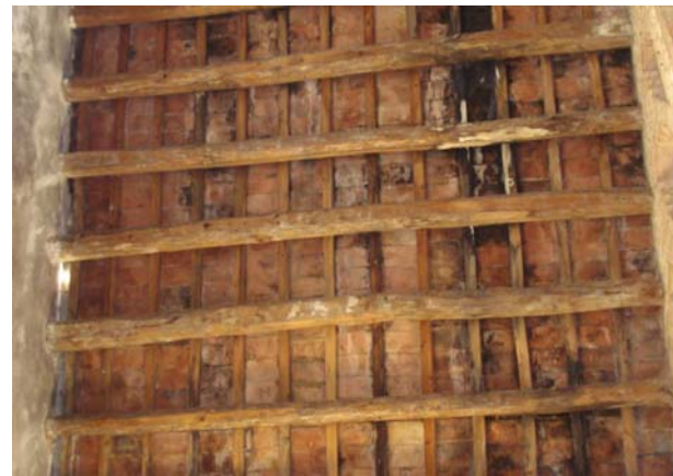
Cubierta – Vista interior
