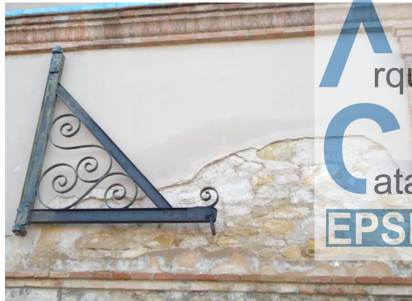
Pared de mampostería con acabado estucado
