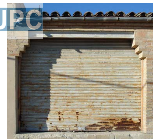
Puerta metálica de muelle de descarga
