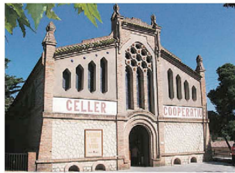
Gran façana. Exterior del celler de Cornudella de Montsant
