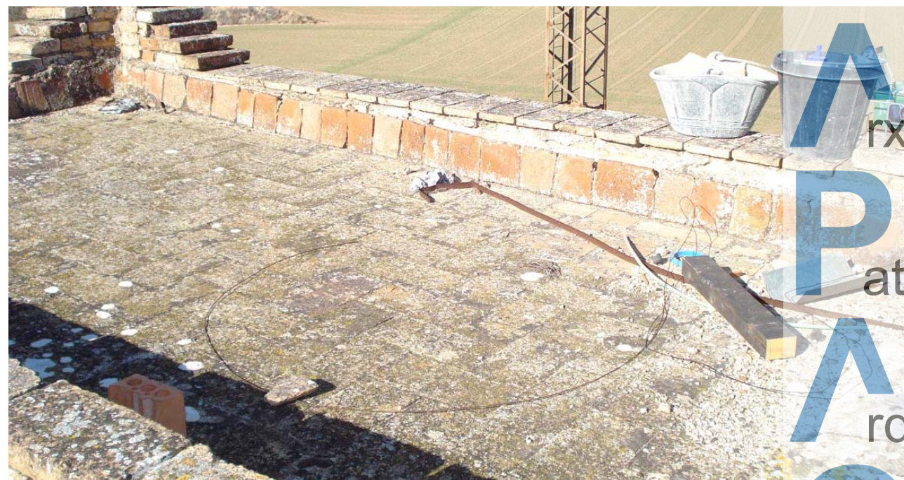
Cubierta plana de la caja de escalera del muelle de descarga
