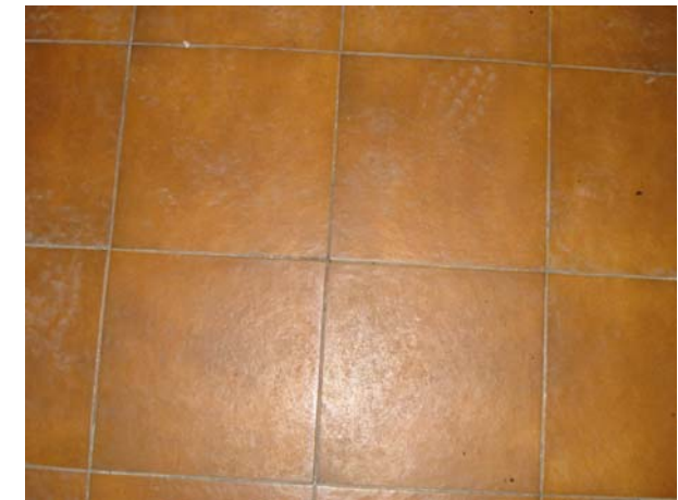
Pavimento de la zona inferior del muelle de descarga
