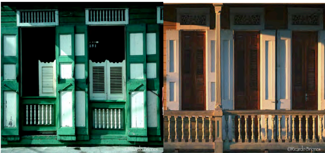
Figura 11. Detalle de doble juego de puertas
