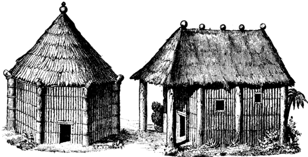
Figura 3. Ejemplo de Bohío (circular) y Caney (rectangular)
