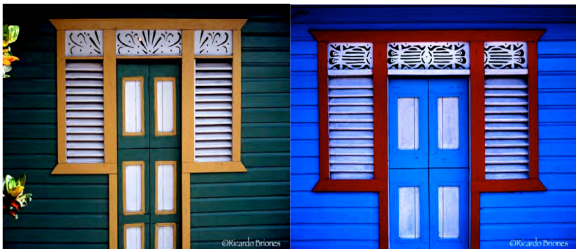
Figura 8. Detalle de Celosías y Calado de Ventiladores
