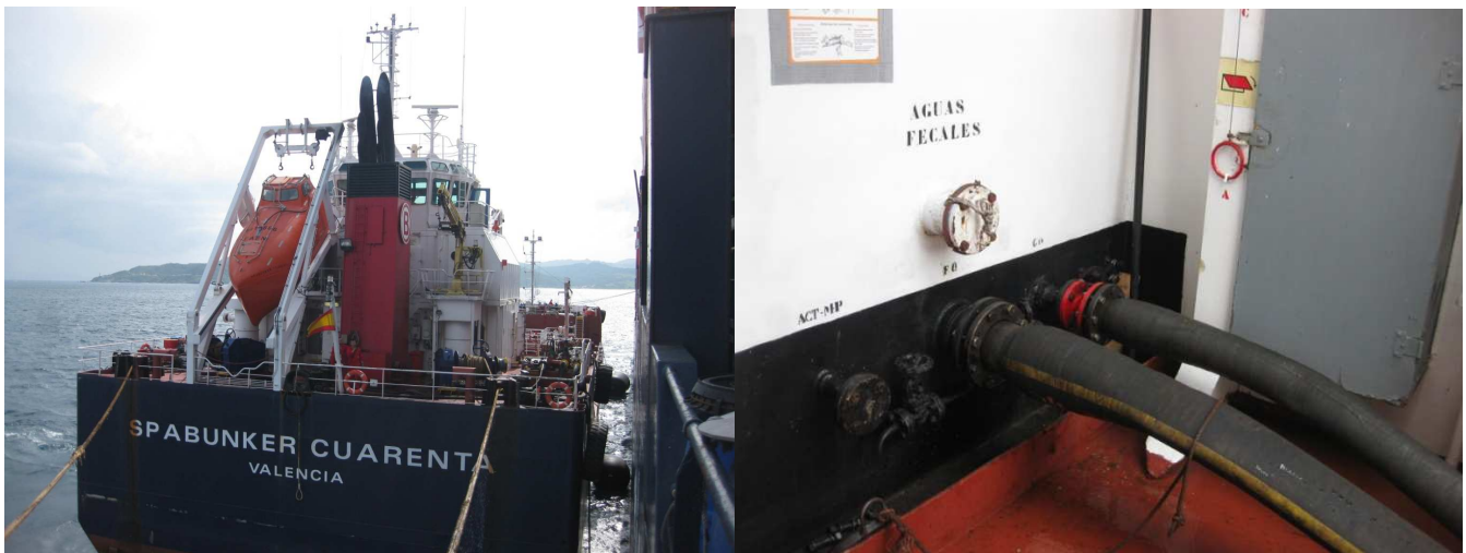
figura 32 y 33. Gabarra de combustible/ Manifold
