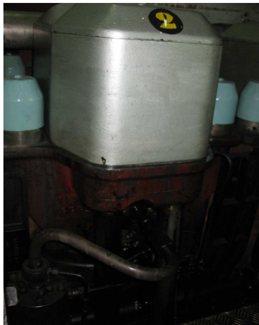
figura 16. Zona “caja caliente” desmontada
