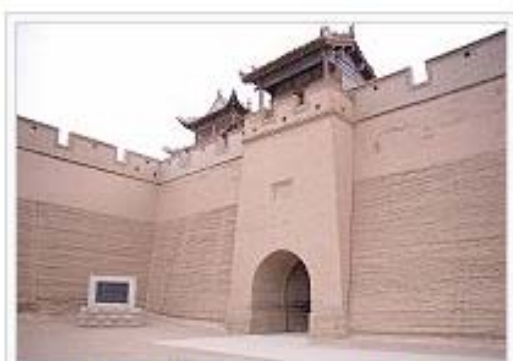
Muralla parcialmente construida con tierra pisada (el nivel superior concluido con ladrillos) ubicada en Jiayuguan , China , edificada durante la dinastía Ming (1368–1644).
