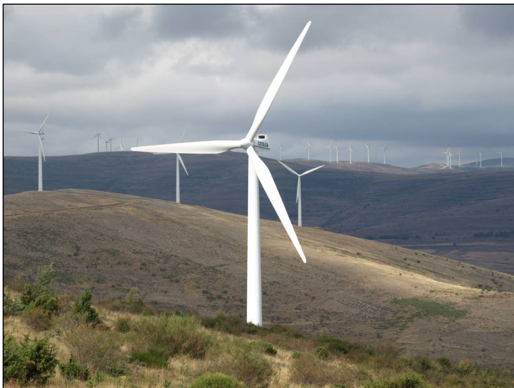
Figura J.13. Aerogeneradores parque eólico (fuente: CETASA)
