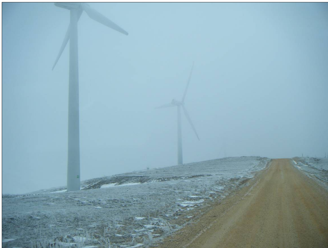
Figura J.1. Accesos parque eólico durante visita de febrero 2010 (fuente: elaboración propia)
