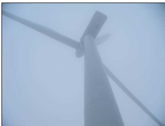
Figura J.2. Detalle aerogenerador, visita febrero 2010 (fuente: elaboración propia)
