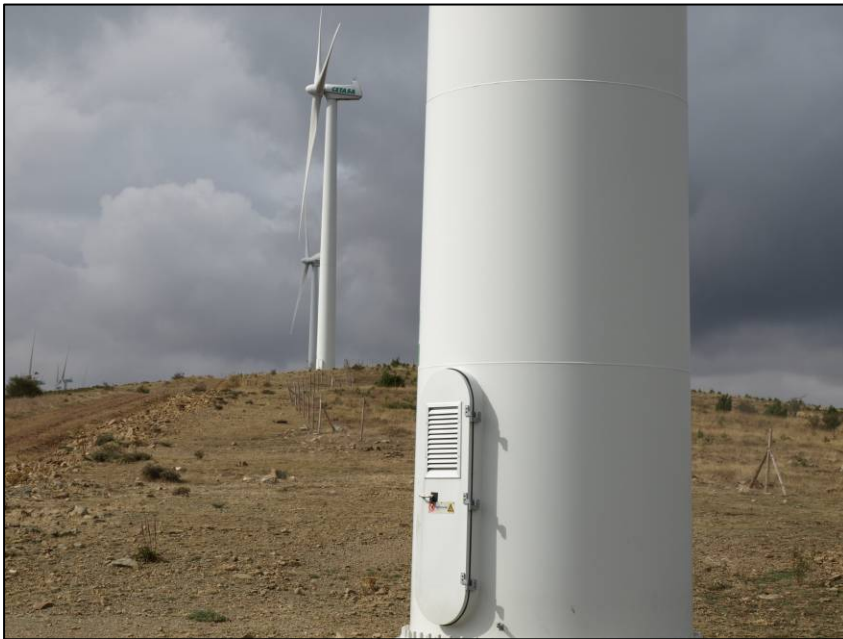
Figura J.11. Torre aerogenerador (fuente: CETASA)
