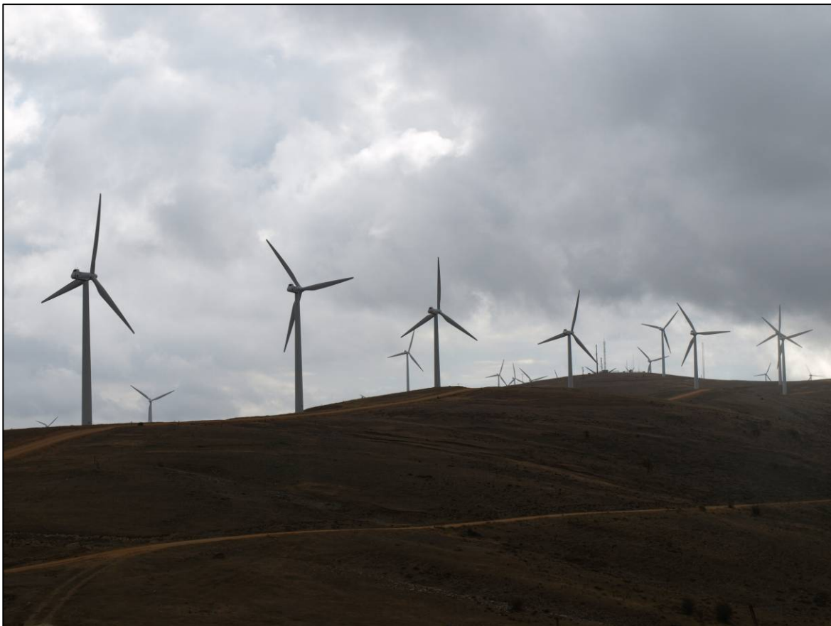
Figura J.12. Aerogeneradores parque eólico (fuente: CETASA)
