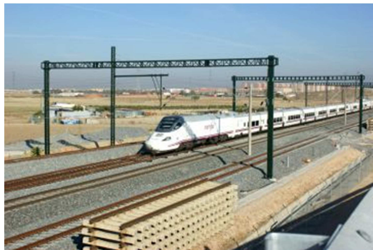
Fig. 1.13 Línea de alta velocidad
