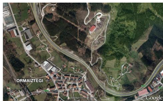
Figura 2.1.3. Autovia GI-632 al seu pas per la població d'Ormaiztegui. Modificat de Google Maps.
