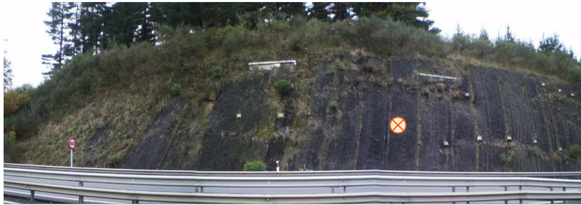
Figura 5.1.2. Talús comprès entre el PK 414,350 i el PK 414,400. La marca circular correspon al sondeig IM-6, realitzat en un tram argilític, d'on s'ha extret posteriorment la mostra IM-6, de la qual se'n ha fet un estudi textural (veure apartat 5.8).
