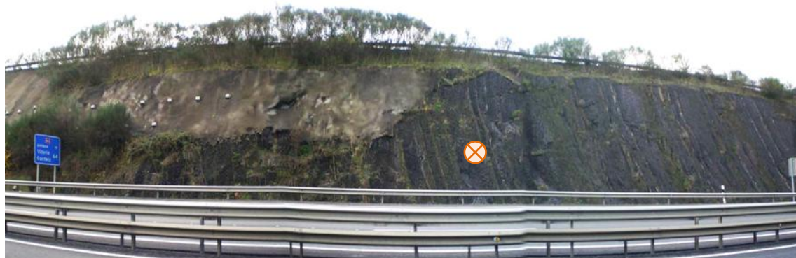
Figura 5.1.3. Talús comprès entre el PK 414,500 i el PK 414,550. La marca circular correspon al sondeig IM-3, realitzat en un tram limolític, d'on s'ha extret posteriorment la mostra IM-3, de la qual se'n ha fet un estudi textural (veure apartat 5.8).
