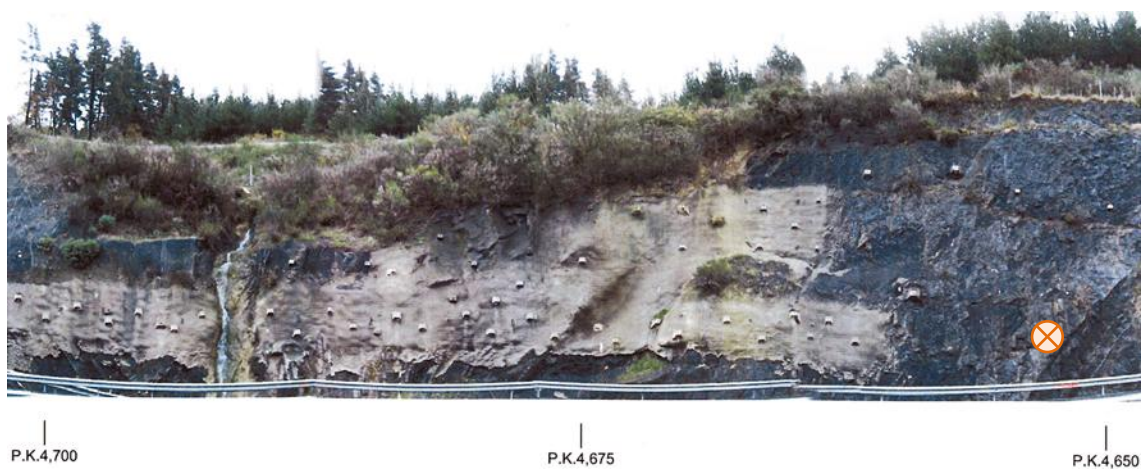
Figura 4.1.3. Talús comprès entre el PK 4.700 i el PK 4.650. La marca circular correspon al sondeig OM-18, realitzat damunt d'una barra de gres, d'on s'ha extret posteriorment la mostra OM-18, de la qual se'n ha fet un estudi textural (veure apartat 4.8).
