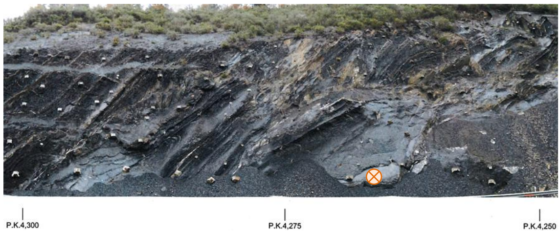
Figura 4.1.2. Talús comprès entre el PK 4.250 i el PK 4.300. La marca circular correspon al sondeig OM-10, realitzat en un tram de limolita nodular, d'on s'ha extret posteriorment la mostra OM-10, de la qual se'n ha fet un estudi textural (veure apartat 4.8).
