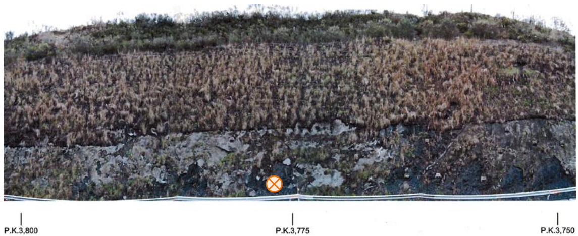
Figura 4.1.1. Talús comprès entre el PK 3.750 i el PK 3.800. La marca circular correspon al sondeig OM-2, realitzat en un tram argilític, d'on s'ha extret posteriorment la mostra OM-2, de la qual se'n ha fet un estudi textural (veure apartat 4.8).
