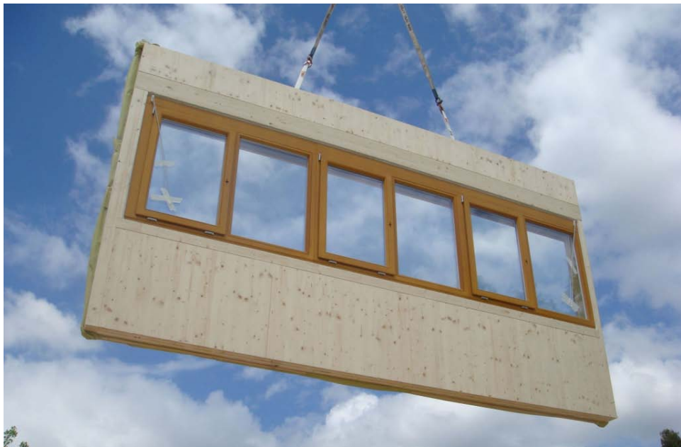
Figura 5. Módulo de fachada durante el montaje de la escuela “Waldorf-Steiner El Til·ler”, Bellaterra, Barcelona.
