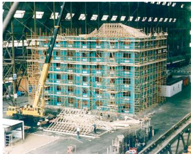
Figura63. Edificio de pruebas para el proyecto Timber frame 2000.
