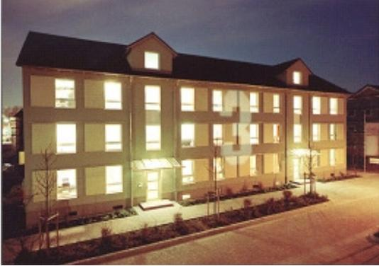
Un nuevo concepto fue desarrollado bajo la coordinación general de Luwoge para la creación de un edificio muy eficiente - no sólo en términos de balance de energía - a partir de componentes innovadores. Yeso con PCM trabajaban en la casa de baja energía, en el año 2001 como parte de la solución del sistema.
