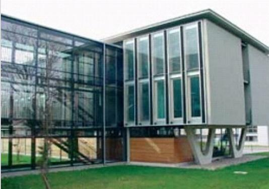
Nuevo edificio de oficinas de la compañía de alimentación Badenova en Offenburg. Como parte de una solución de climatización pasiva, se utilizó yeso con Micronal.
