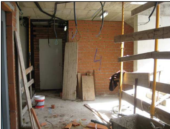
Foto 4.40 i 41: Distribució de cablejat i enllumenat interior i vestíbuls
