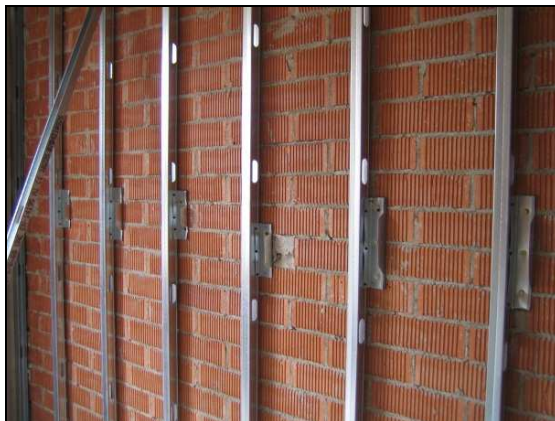
Foto 4.23: Perfilaria de trasdossat
