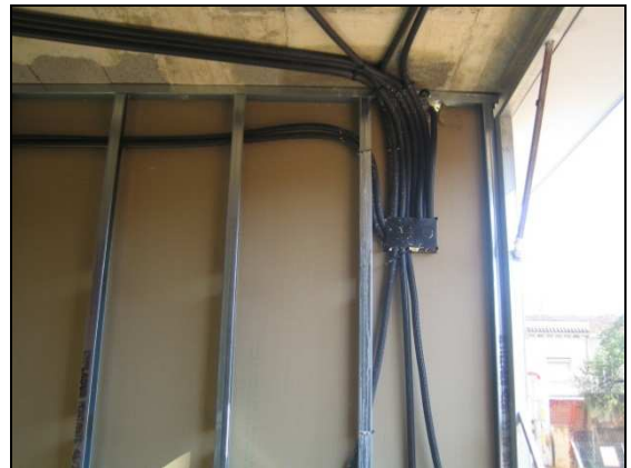
Foto 4.40 i 41: Distribució de cablejat i enllumenat interior i vestíbuls
