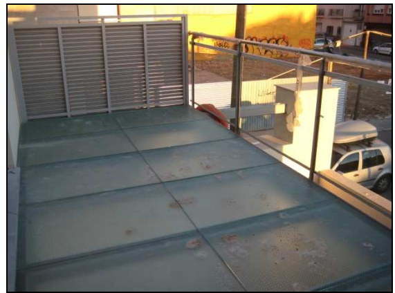
Foto 4.32: Paviment de vidre
