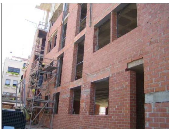
Foto 4.16: Tancaments vista exterior
