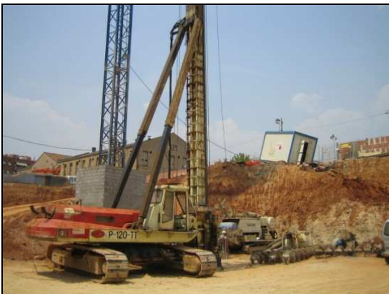
Foto 4.5: Maquinària de pilotatge
