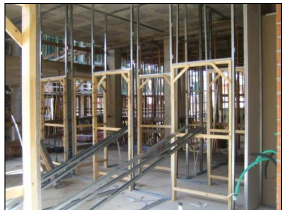
Foto 4.21: Tancaments interiors perfilaria
