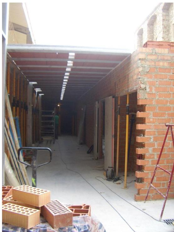
Figura 4.3. 6 Preparación forjado zona de basuras
