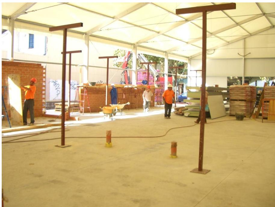
Figura 4.3. 1 Inicio estructura metálica
