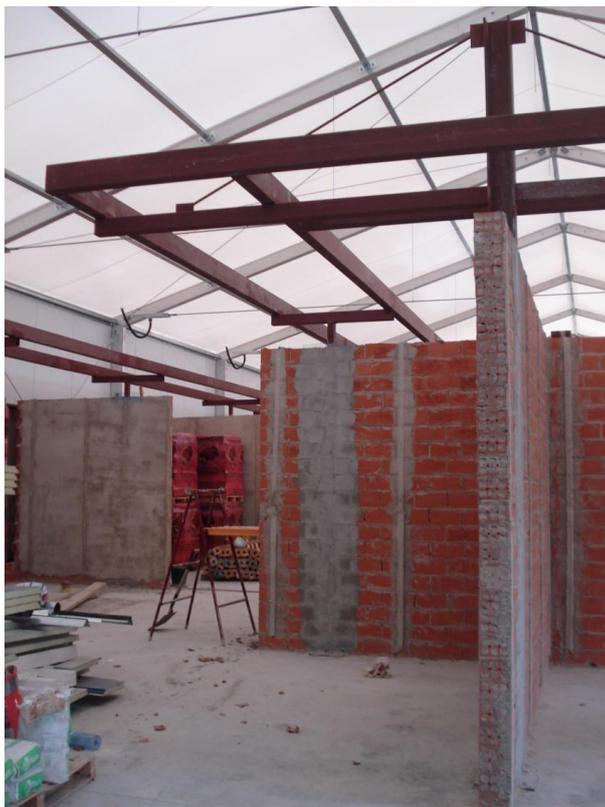
Figura 4.3. 3 Unión tabique con estructura metálica
