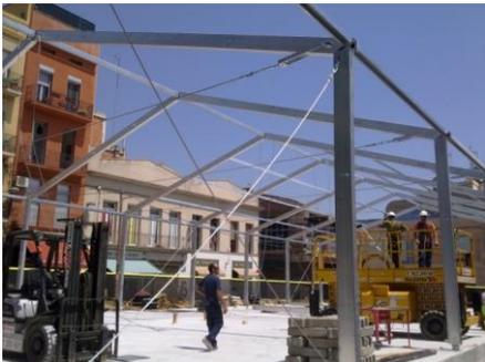
Ya se empieza a montar la estructura de la carpa. Todos los pórticos metálicos fijados al suelo y con el cable de sujeción de la carpa colocado.
