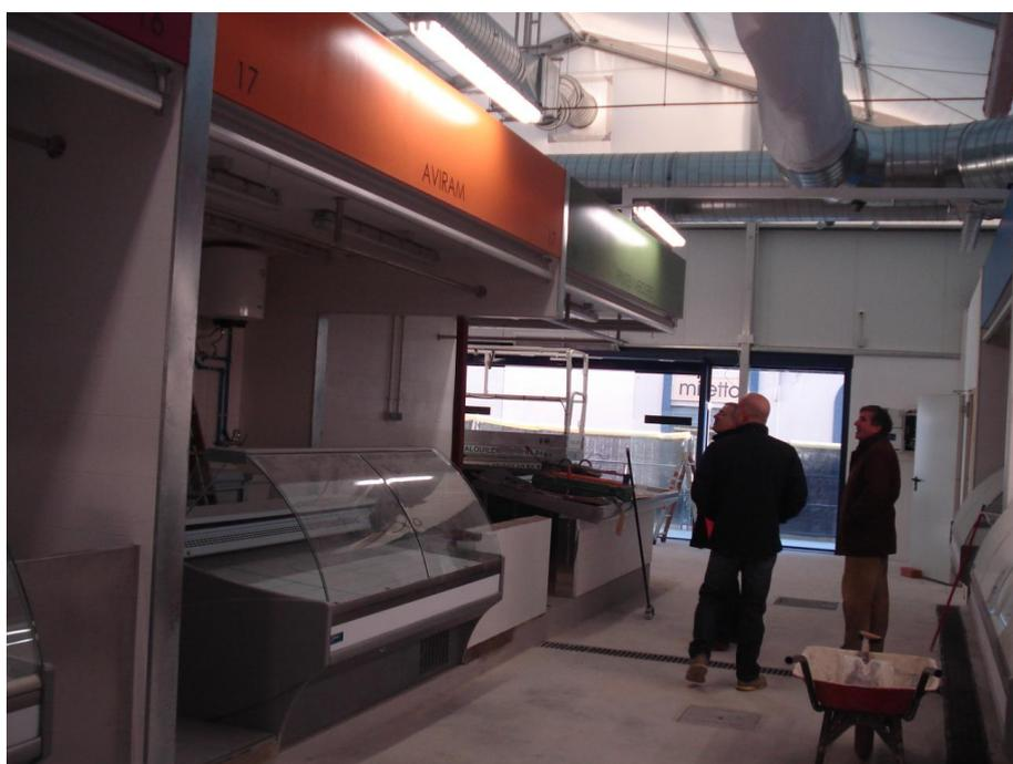
Figura 4.3. 16 Instalación tubo textil
