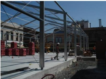
Se colocan los cables tanto los laterales como los del techo. Y posteriormente se tensan.
