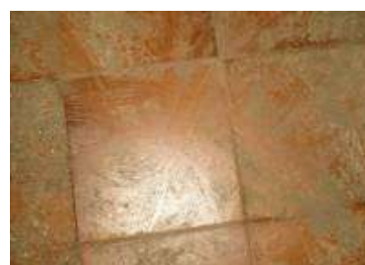
Paviment de rajola ceràmica de 31x31 a planta segona
