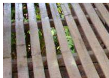
Llatges de fusta per a fer les plantes estenedors transitables (P4 a P6)
