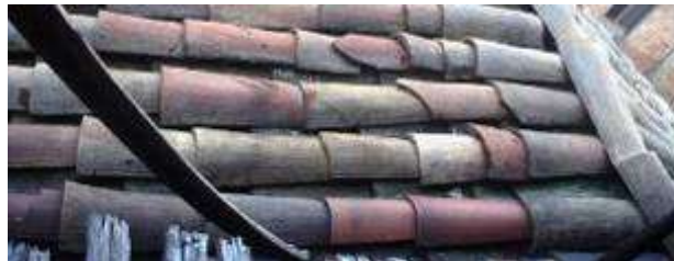
Figura 5.50 Teulada de la coberta del tram original
