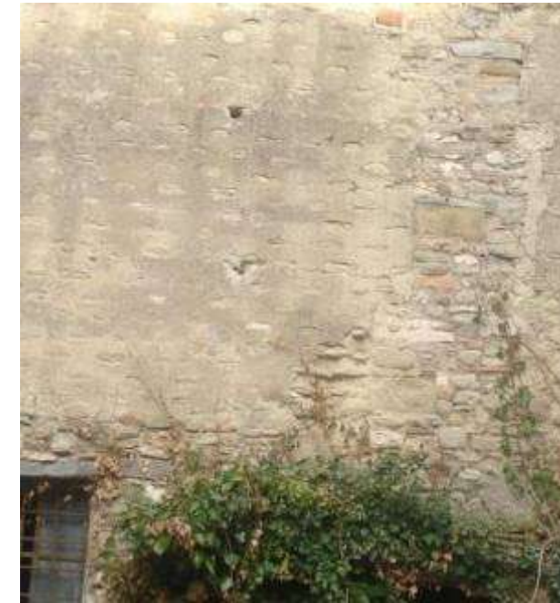
Figura 5.35 Tram Planta segona façana Oest. Estructura vertical. Trobament del mur de tàpia amb els pilars i mur de maçoneria.
