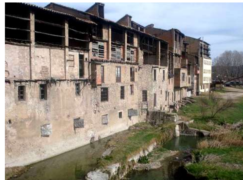
Figura 3.5 Vic, 2010. Conjunt de fàbriques del barri de les adoberies de Vic amb les plantes superiors destinades a l'assecat de les pells.
