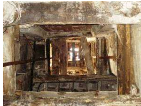
Figura 5.29 Des de Planta baixa, els forats practicats a cada una de les plantes per a permetre el desplaçament en vertical del muntacàrregues.
