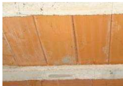
Figura 5.37 Forjat de biguetes de formigó prefabricat i revoltons ceràmics sostre P1 de l'annex. Aquest forjat és posterior, de finals del segle XX.
