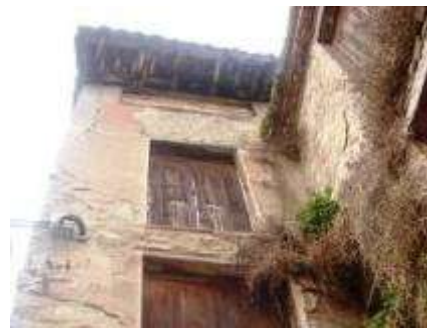
Figura 5.59 Arrebossat façana principal
