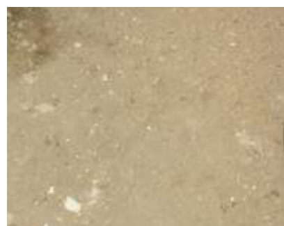
Paviment de formigó sobreposat a planta primera
