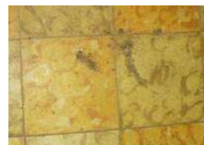
Paviment de rajola ceràmica amb estampat i a dos colors de 25x25cm a planta segona.
