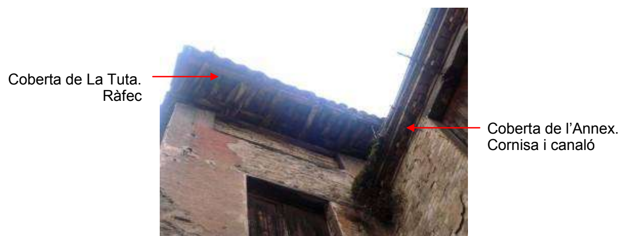
Figura 5.56 Ràfec de La tuta i cornisa amb canal de recollida d'aigües de l'Annex
