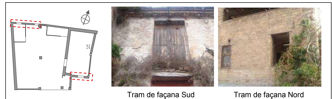
Figura 5.43 Tram de façana Sud, planta segona de l'Annex, amb maó massís col·locat pla, i tram de façana Nord a les plantes segona (tancament) i tercera (barana) amb maó massís col·locat de cantell.
