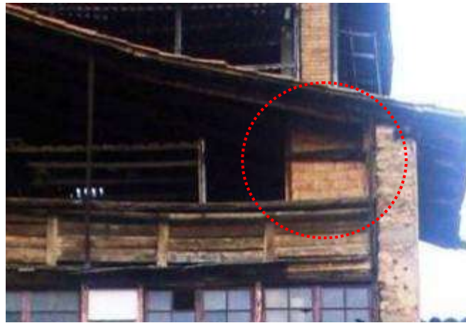
Figura 5.28 Planta tercera. Cabina del muntacàrregues vista des de l'exterior.
