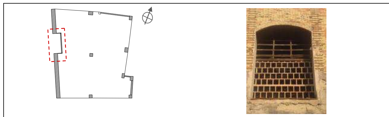
Figura 5.45 Obertura a la façana Oest de l'edifici. Comença a planta tercera fins la cinquena.
