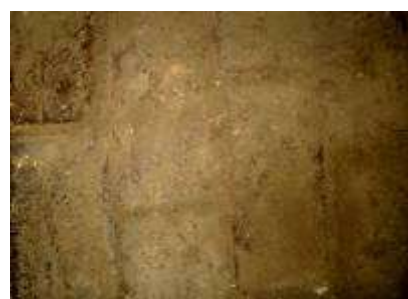
Paviment de cairó català de 10x18 cm al replà d'escala de P2 a P3
