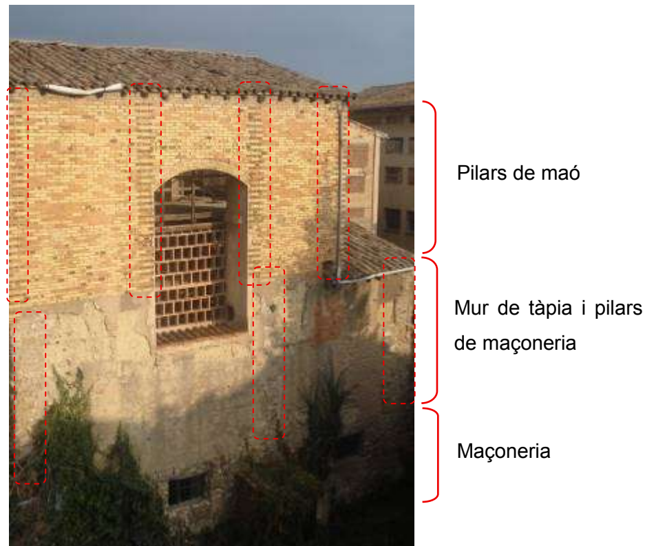
Figura 5.34 Façana Oest. Estructura vertical. Maçoneria, tàpia i fàbrica de maó.
