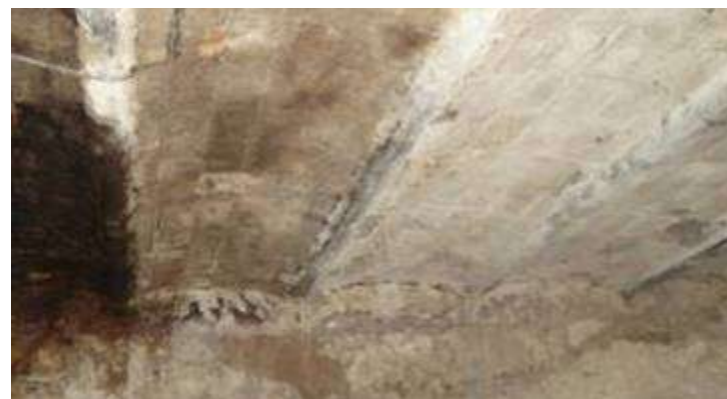
Figura 5.38 Forjat de biguetes metàl·liques i revoltons de rajols. Sostre PB de l'annex. Forjat no original, segles XIX - XX.
