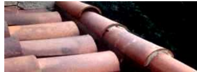
Figura 5.51 Teules Obertura façana oest
