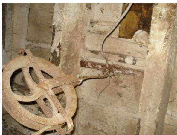
Figura 5.81 Sistema de politges per a l'extracció d'aigua dels pous.
