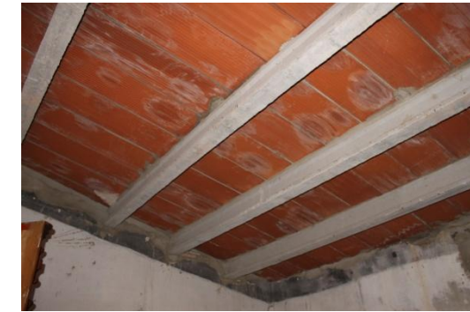
Coberta Habitació PP Rehabilitada
