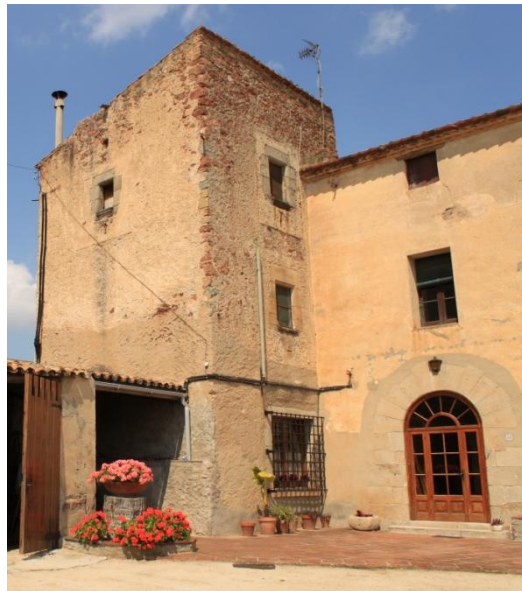
Fig.5.3. Torre de Defensa
