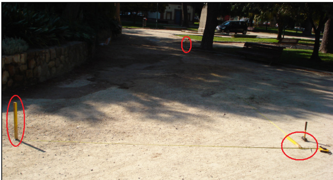
Fig.60, Puntos materializados mediante estacas delimitando una futura malla.
