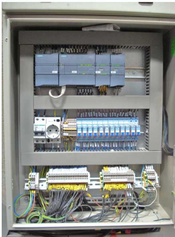
Fig.27. Quadre Control Compressors en planta.
