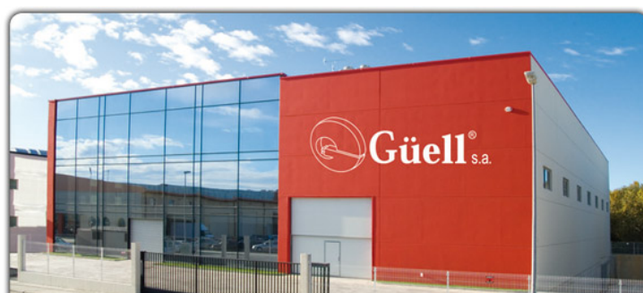
Fig. 1. Eléctrica Güell, S.A.
