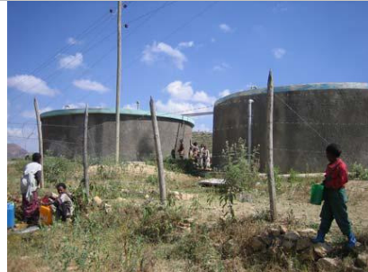
Depósitos de Agua construidos por Ingenieros para la Cooperación
