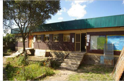
Policlínico construido por PRO-PRIDE
