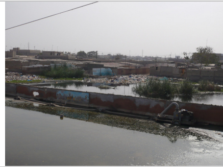
Vista de inundaciones
