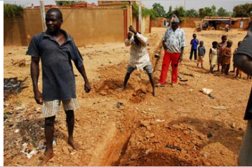
Construcción de Red REFAID
