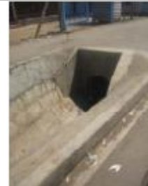
Mejora de drenaje Pluvial
