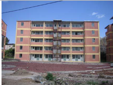
Vivienda en construcción
