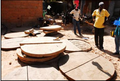
Construcción de las losas para los pozos de aguas grises por la ONEA
