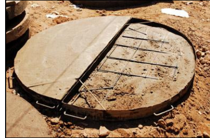
Construcción de las losas para los pozos de aguas grises por la ONEA
