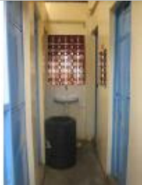
Interior Bloque Saneamiento
