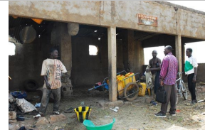
Depósito de transición de Residuos
