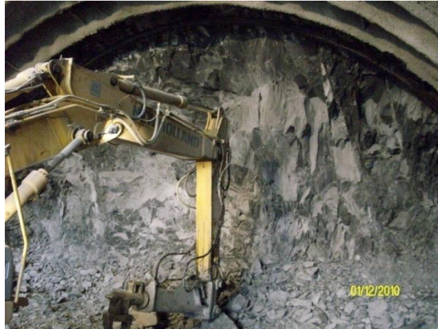
Figura 4.13:labores de saneo
