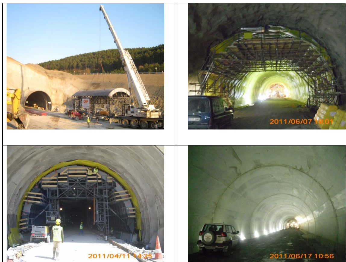
Figura 4.16: fases de montaje de carro de encofrado de revestimiento
