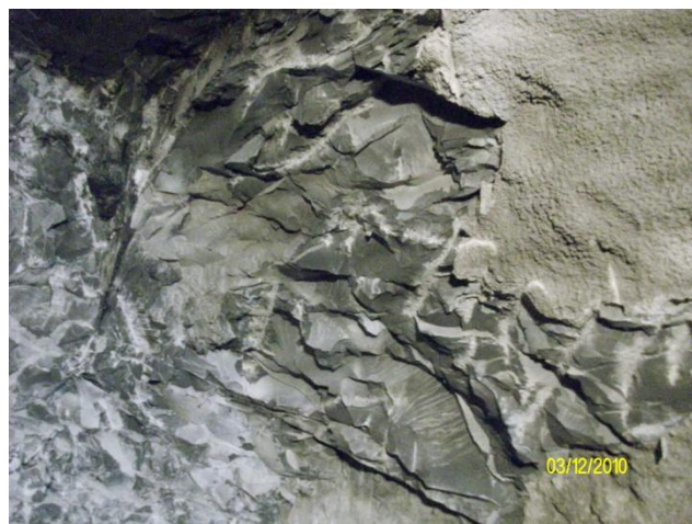
Figura 4.6: marga en el macizo excavado
