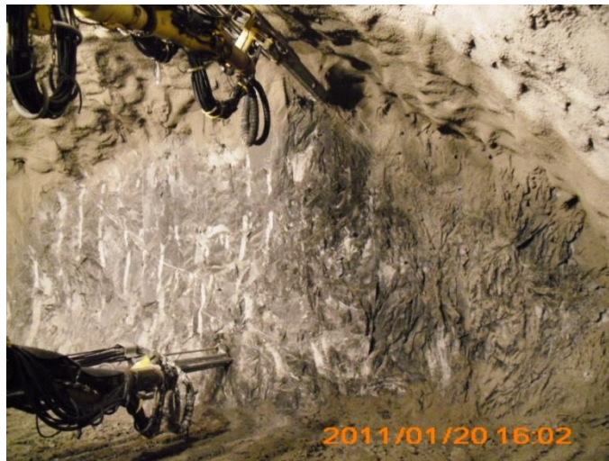
Figura 4.11:jumbo perforando barrenos.
