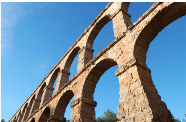
Fig. 77 – Aqueduct of Las Ferreras view from the bottom (Ajuntament de Tarragona)
