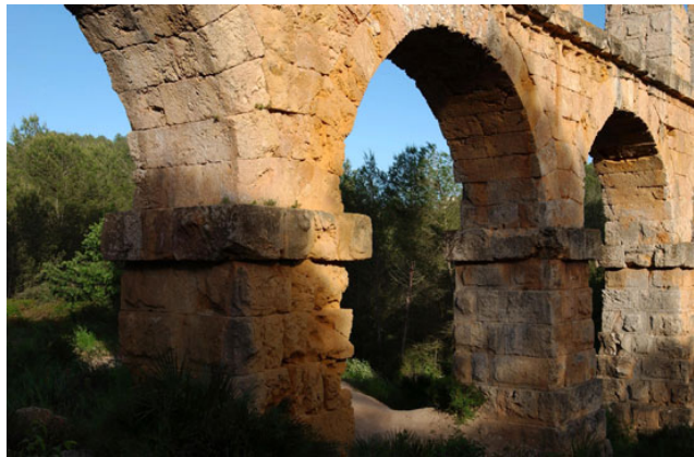
Fig. 76 – Aqueduct of Las Ferreras detail view (Ajuntament de Tarragona)
