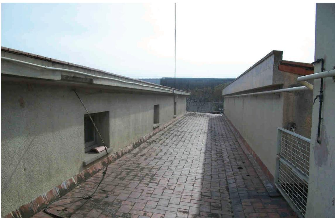
*En esta fotografía se puede observar las dos tipologías de cubierta. A la derecha está la cubierta ventilada y en la izquierda la cubierta de losa de hormigón.*
