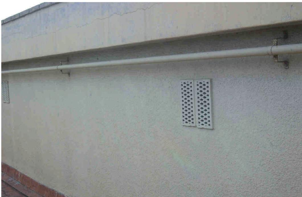
*En esta fotografía se puede observar la ventilación de la cubierta ventilada.*
