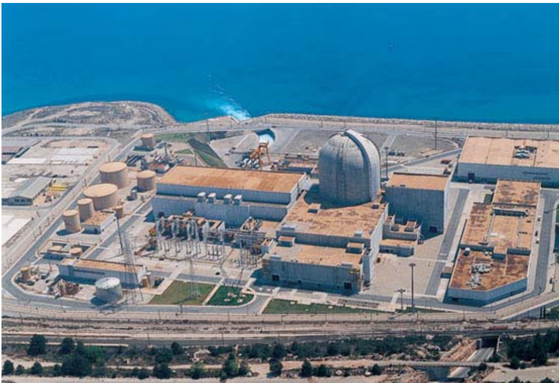
Central nuclear de Vandellós II (Tarragona)
