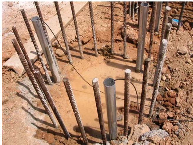
Figura 2.11: Pilote con previsión de tubos para el ensayo Cross-Hole
