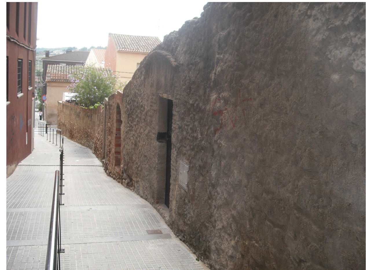
21. Façana Est, tanca del pati
