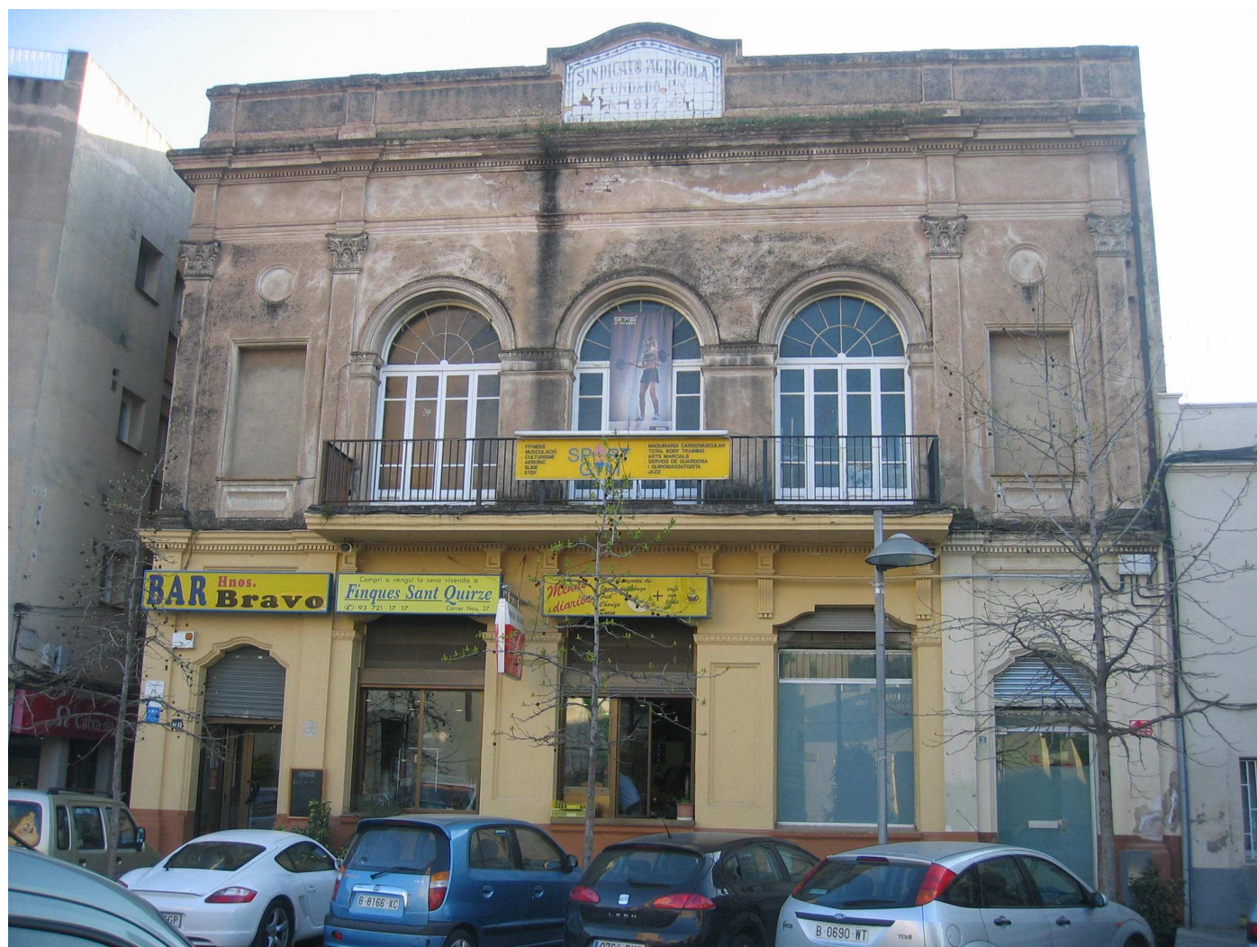
5. La façana principal s'articula en quatre pilastres que atorguen un protagonisme especial a les tres portes de la balconada amb arcs de mig punt, a planta baixa trobem tres grans finestrals alineats amb les mateixes portes i d'una manera més dissimulada trobem les dues portes d'accés, de tal manera i alineades trobem dos finestrals tapiades.
