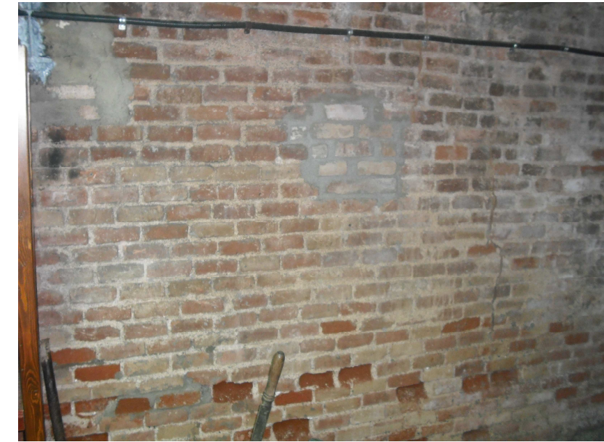
31. Mur de fàbrica
