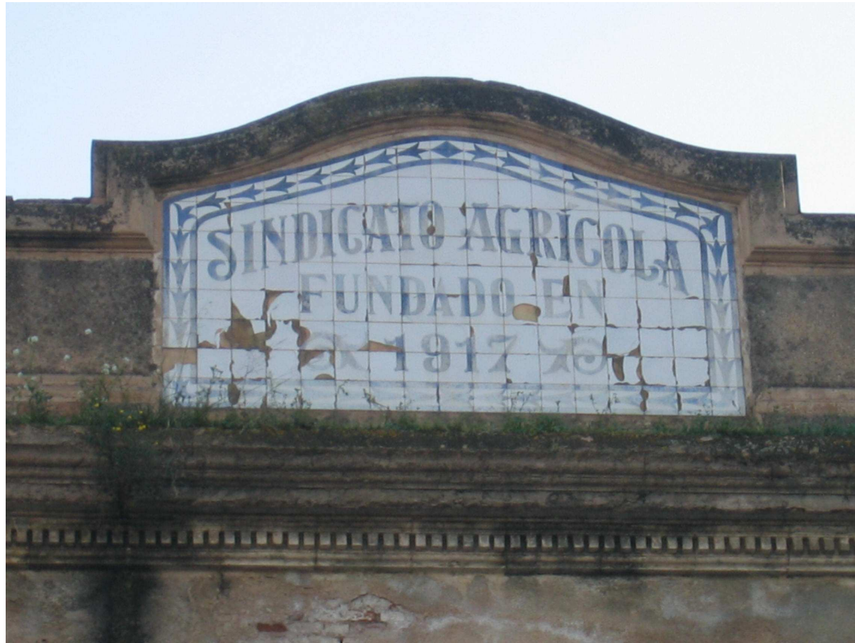
18. Detall de la retolació original en peces de rajola. L'Any 1917 va ser l'any de la fundació del Sindicato Agrícola. La construcció d'aquest edifici fou al 1923
