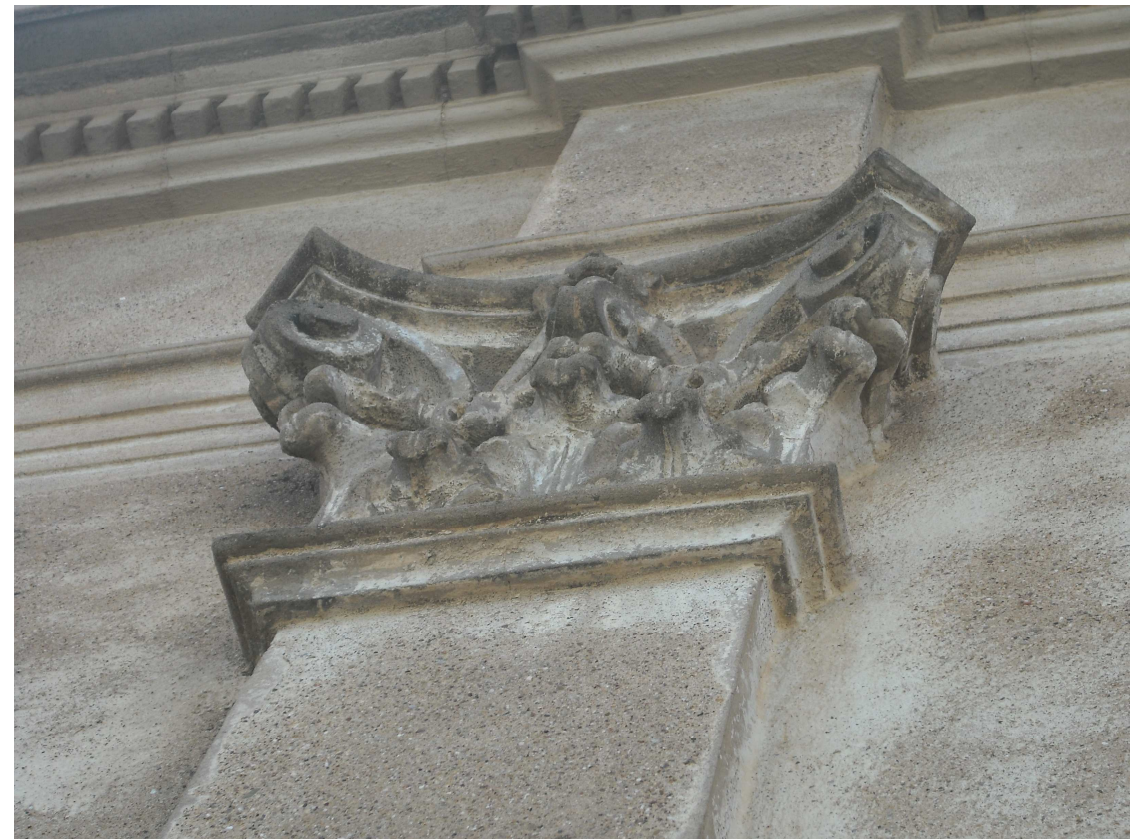
17. Detall del capitell d'estil corinti de les pilastres
