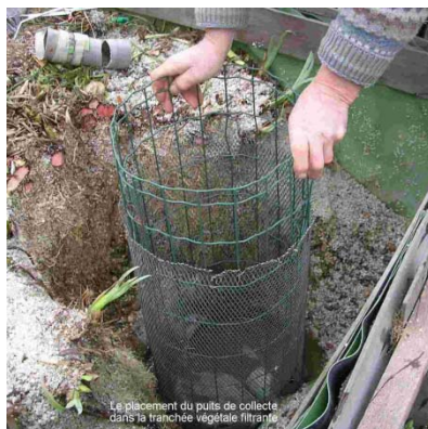
Imagen 30: Pozo de recolección de agua
