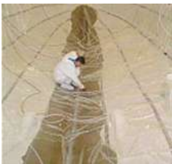
Img. 32. Colocación bolsa de vacío
